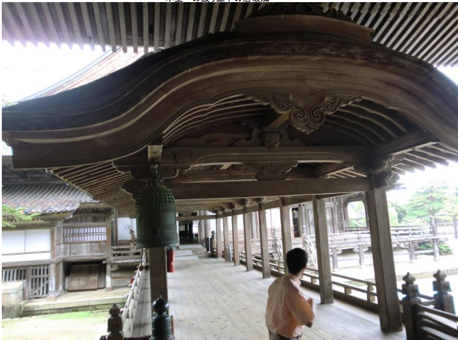
本堂への渡り廊下の唐破風
