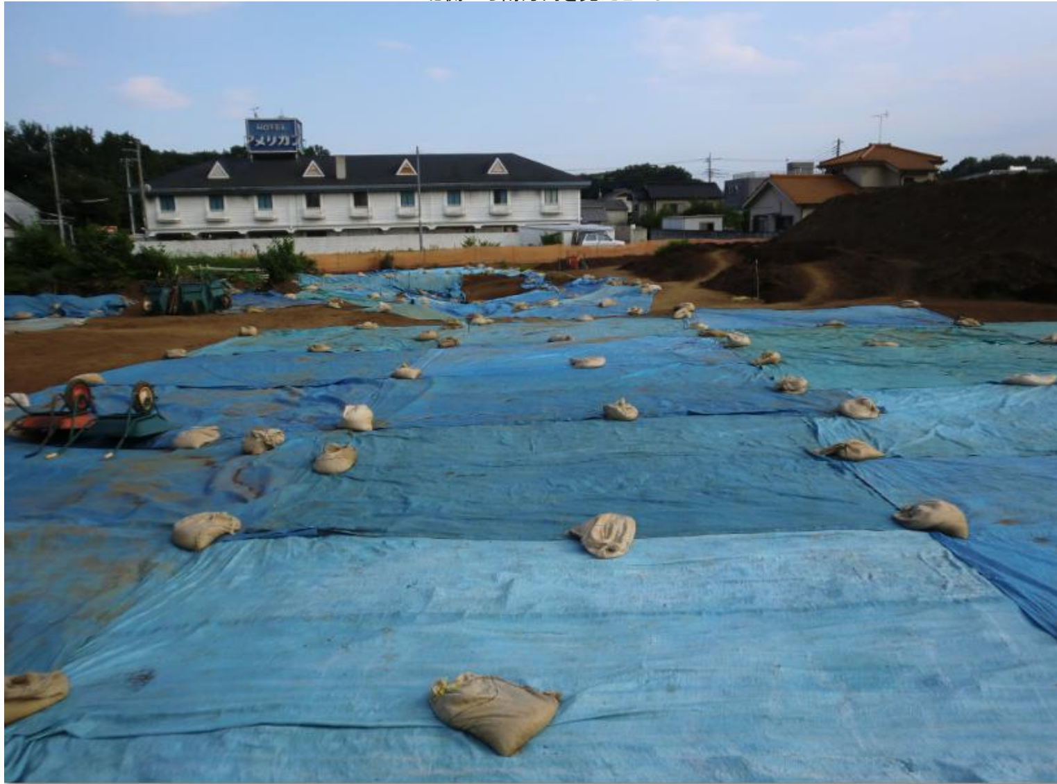
北側から南方向を見たところ
