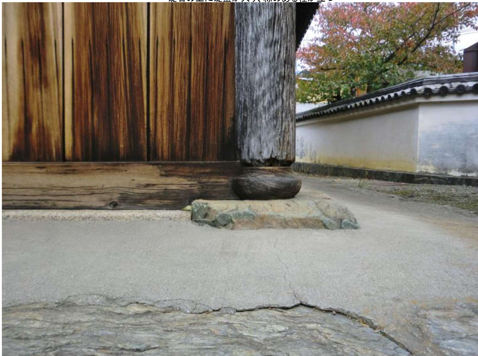
礎石の上に礎盤が入り、粽のある柱が立つ
