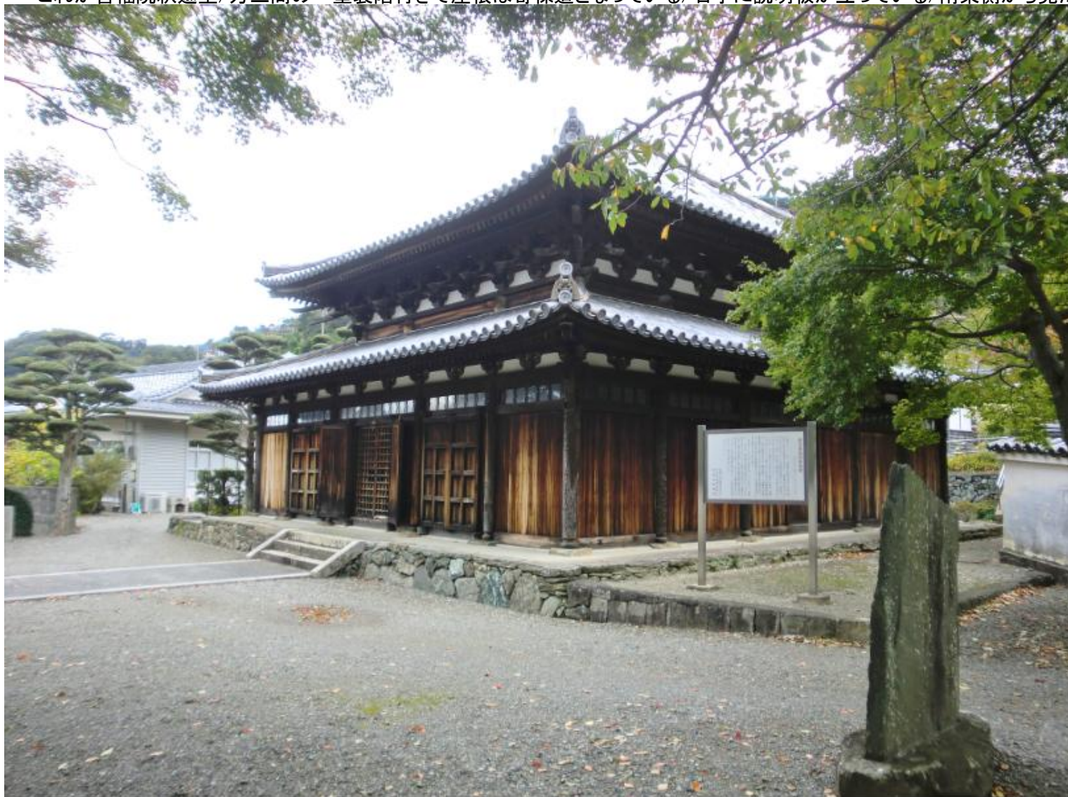
これが善福院釈迦堂/方三間の一重裳階付きで屋根は寄棟造となっている/右手に説明板が立っている/南東側から見たところ
