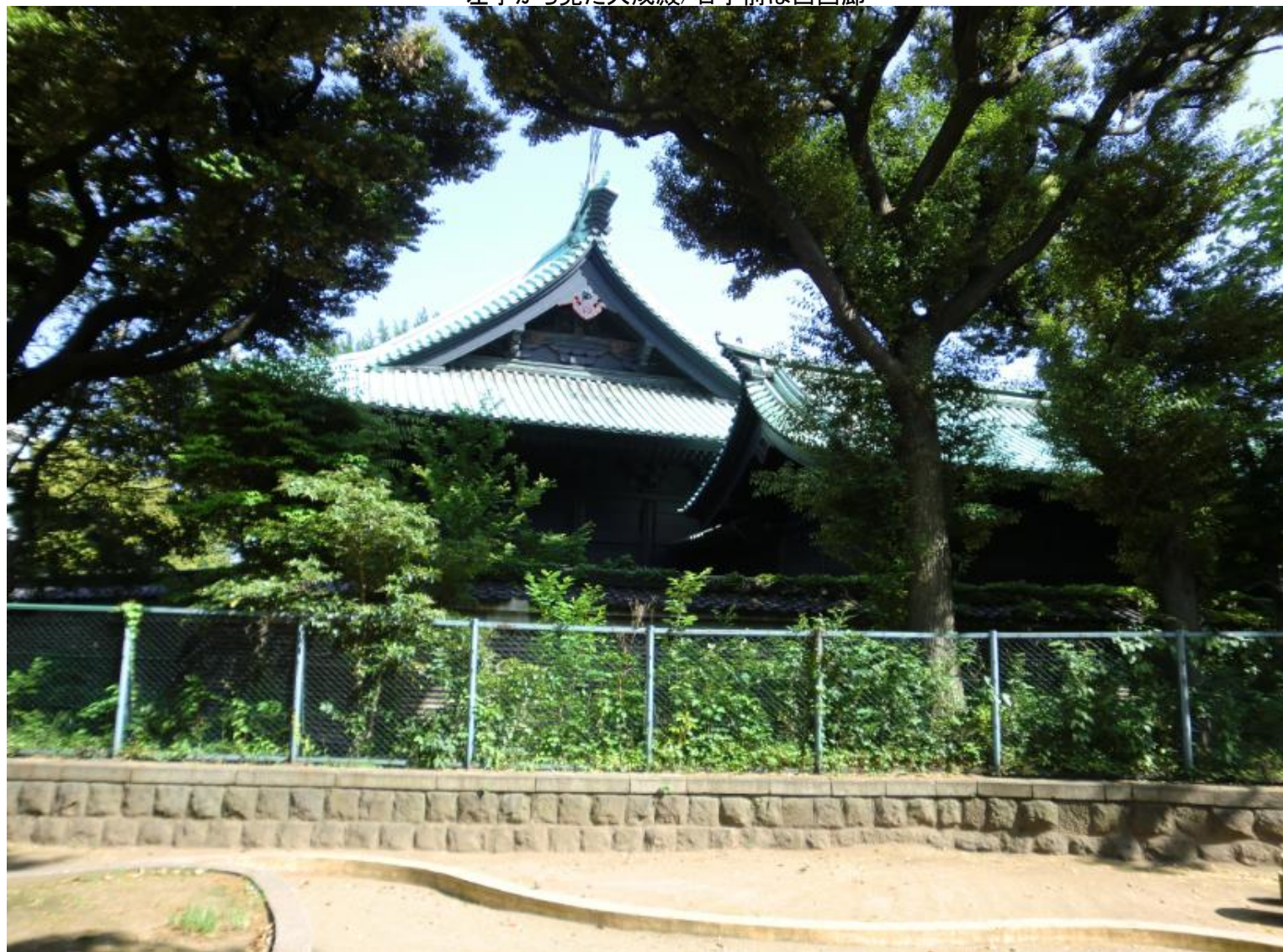
左手から見た大成殿/右手前は西回廊
