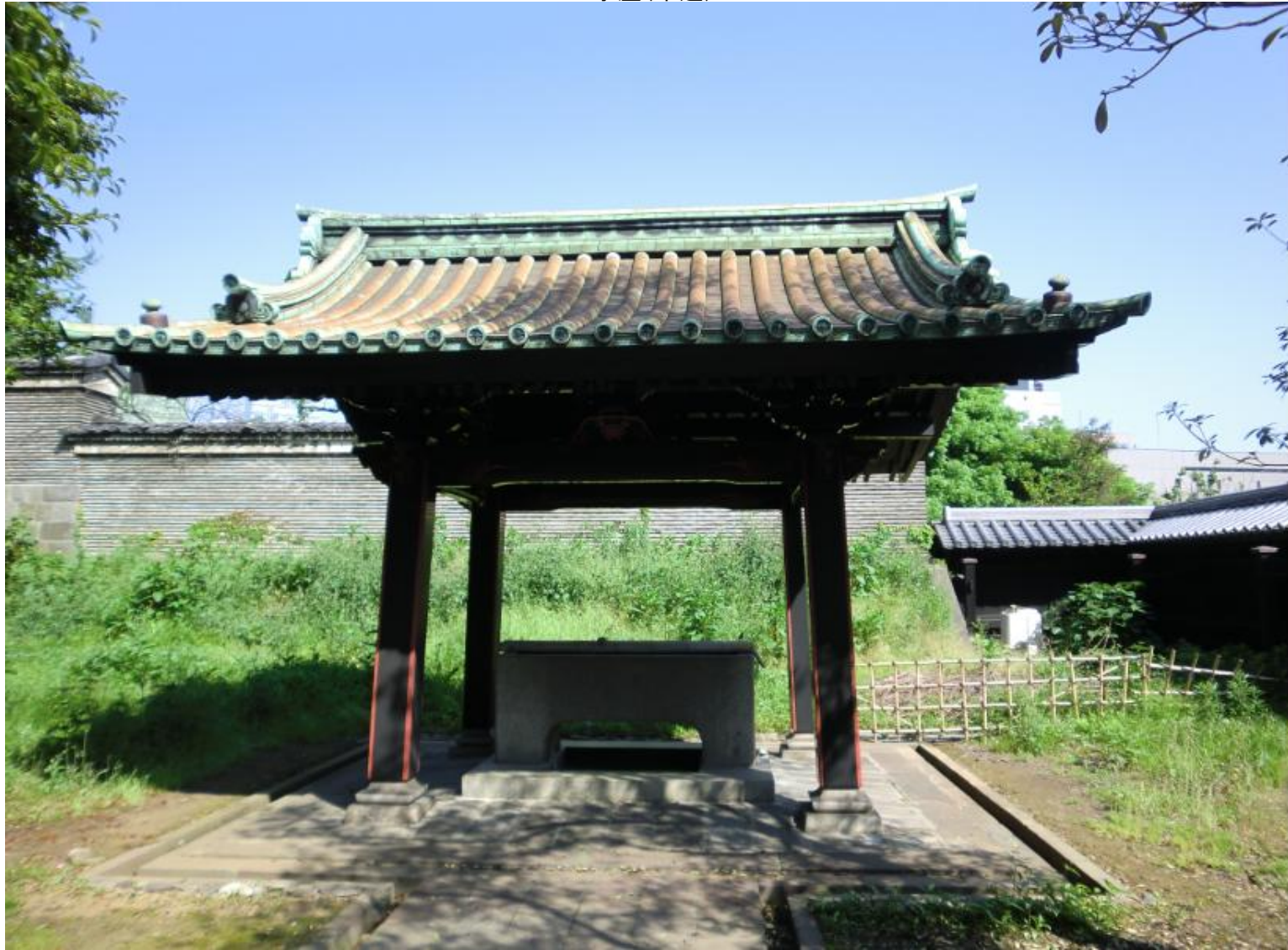
関東大震災ではこの水屋と入徳門が焼け残った (この水屋の改修は松浦愛一郎・一・弘二の三人が携わったという)
