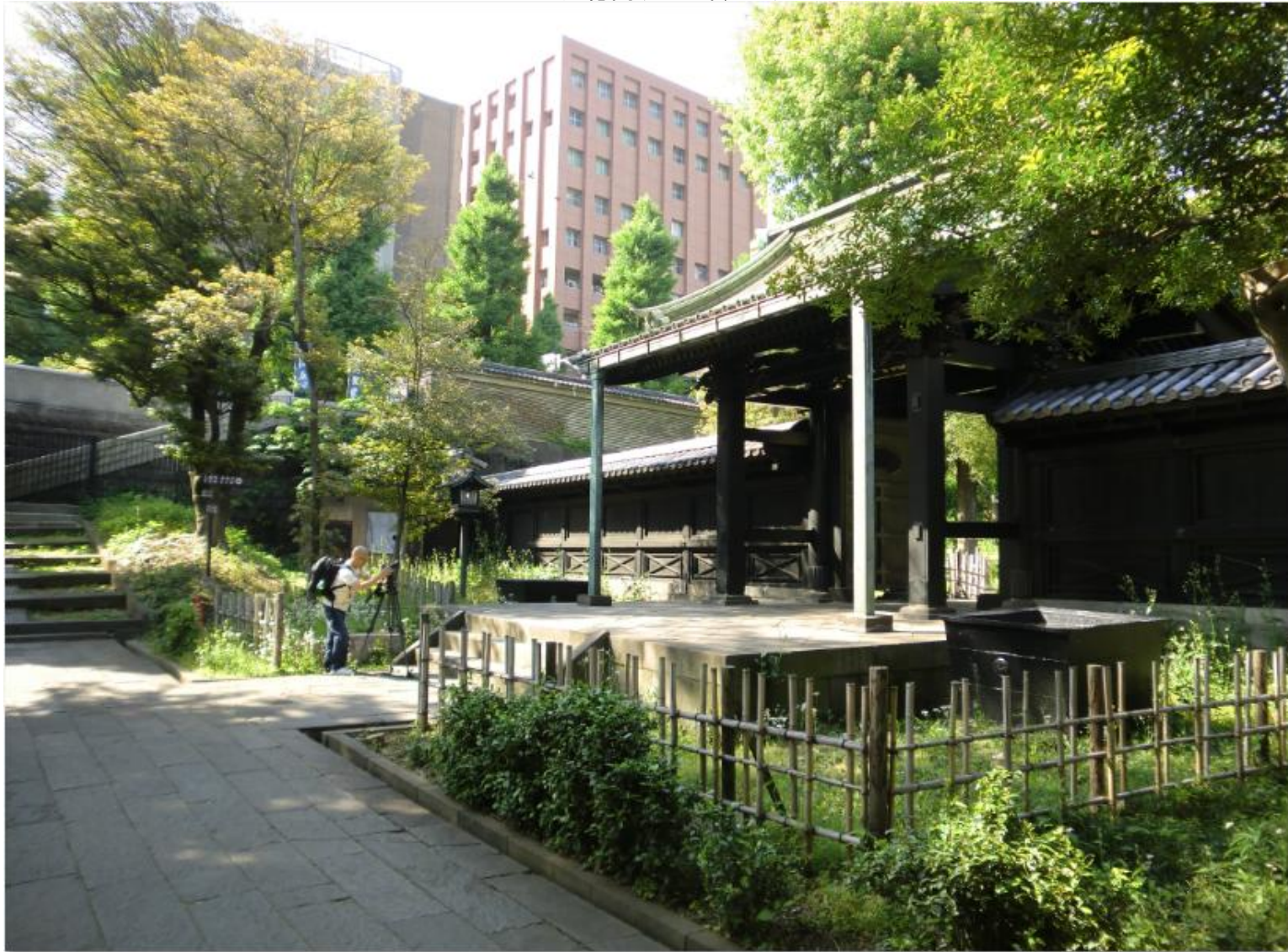
昭和9年に大林組の下請けで松井組(工事担当は松浦愛一郎)が改修した(木造)
