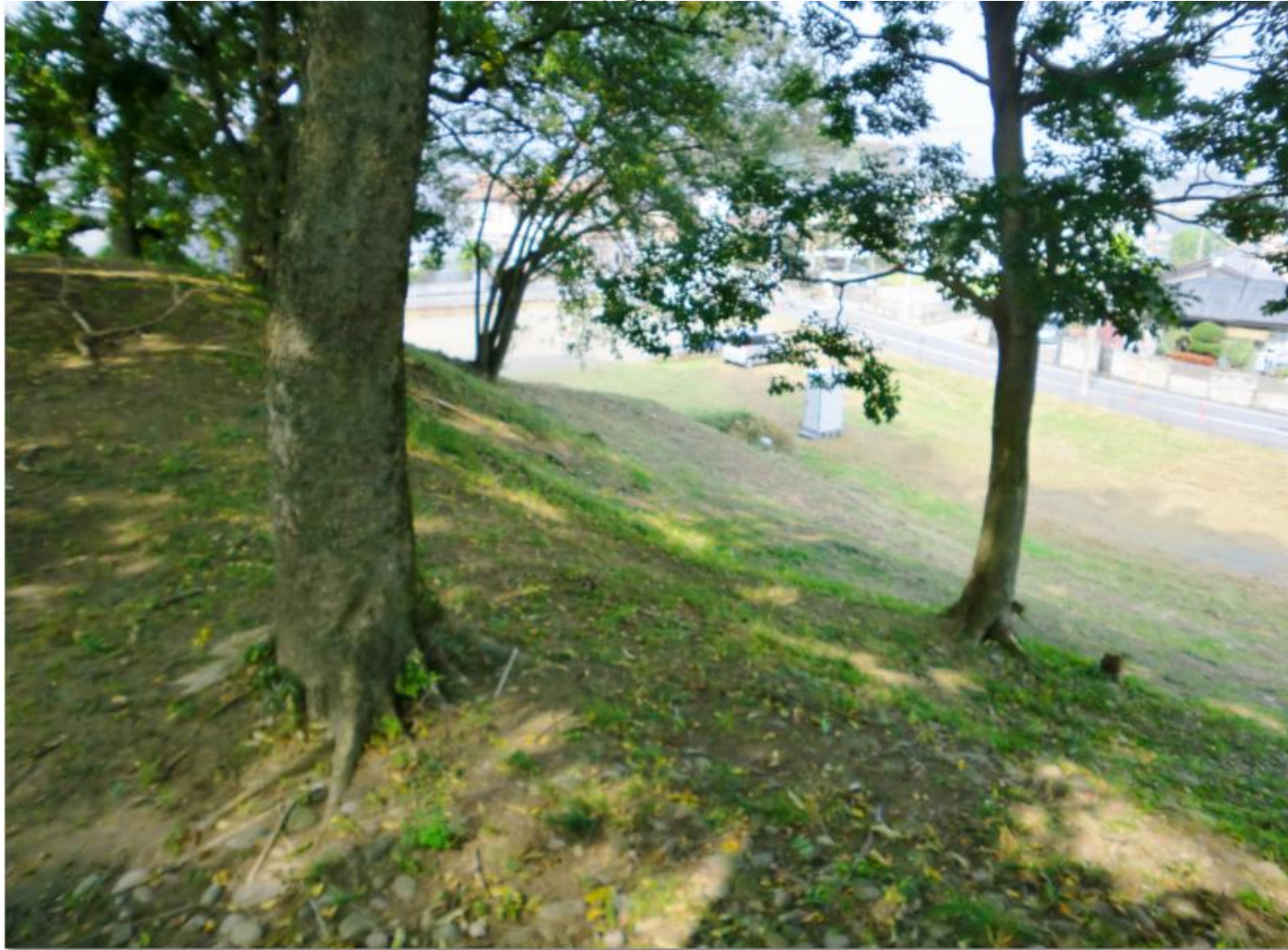
同じく右手を見下ろしたところ
