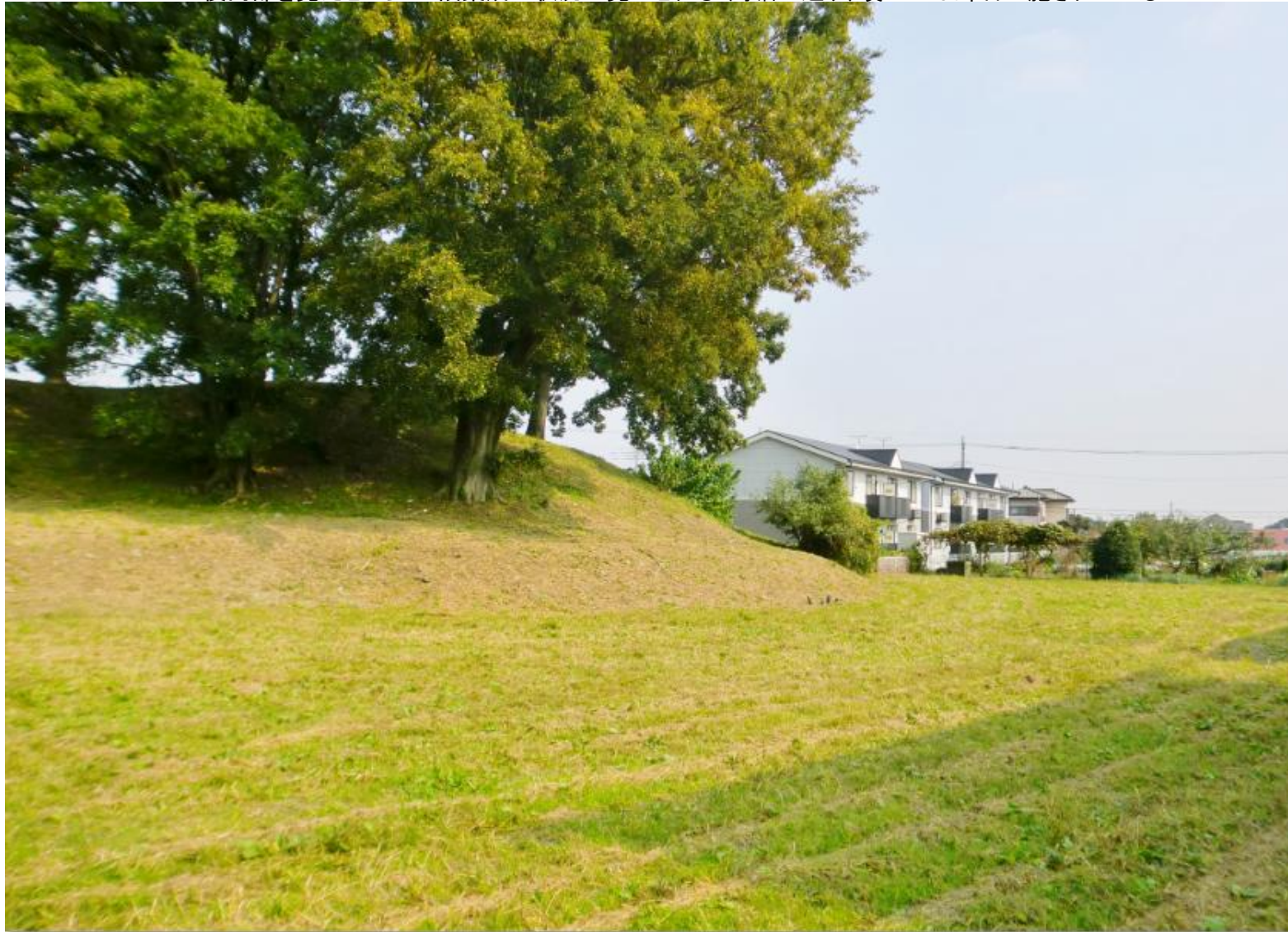
後田部を見たところ/二段築成の状況が見てとれる/周堀が巡り、墳丘には葺石が施されている
