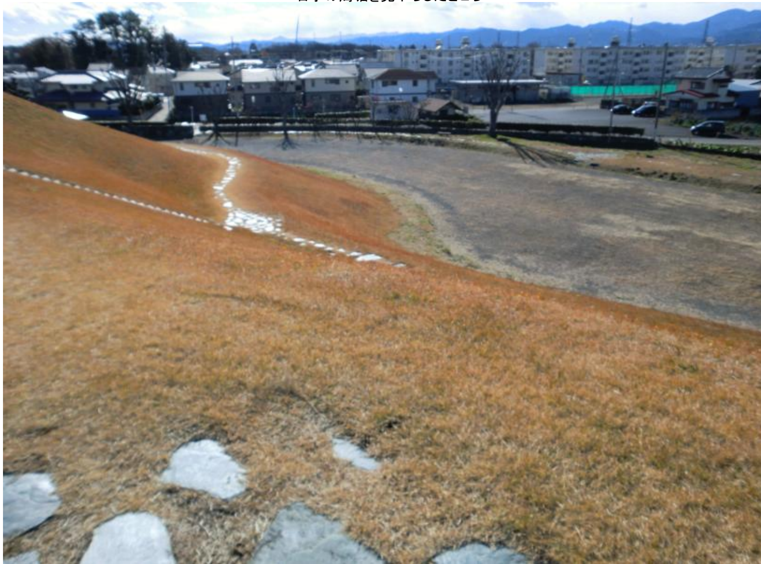
右手の周堀を見下ろしたところ
