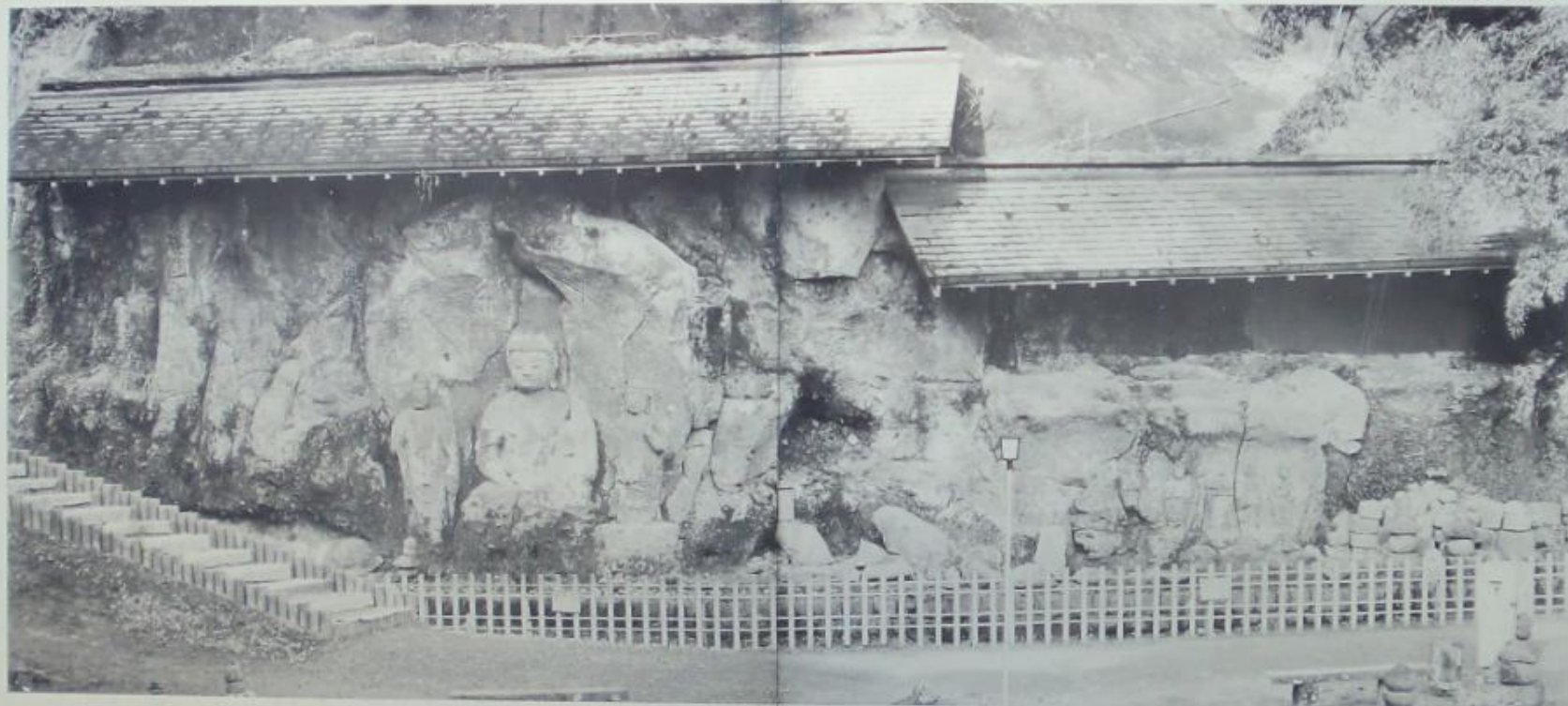
保存修理工事着手前のホキ石仏第二群
