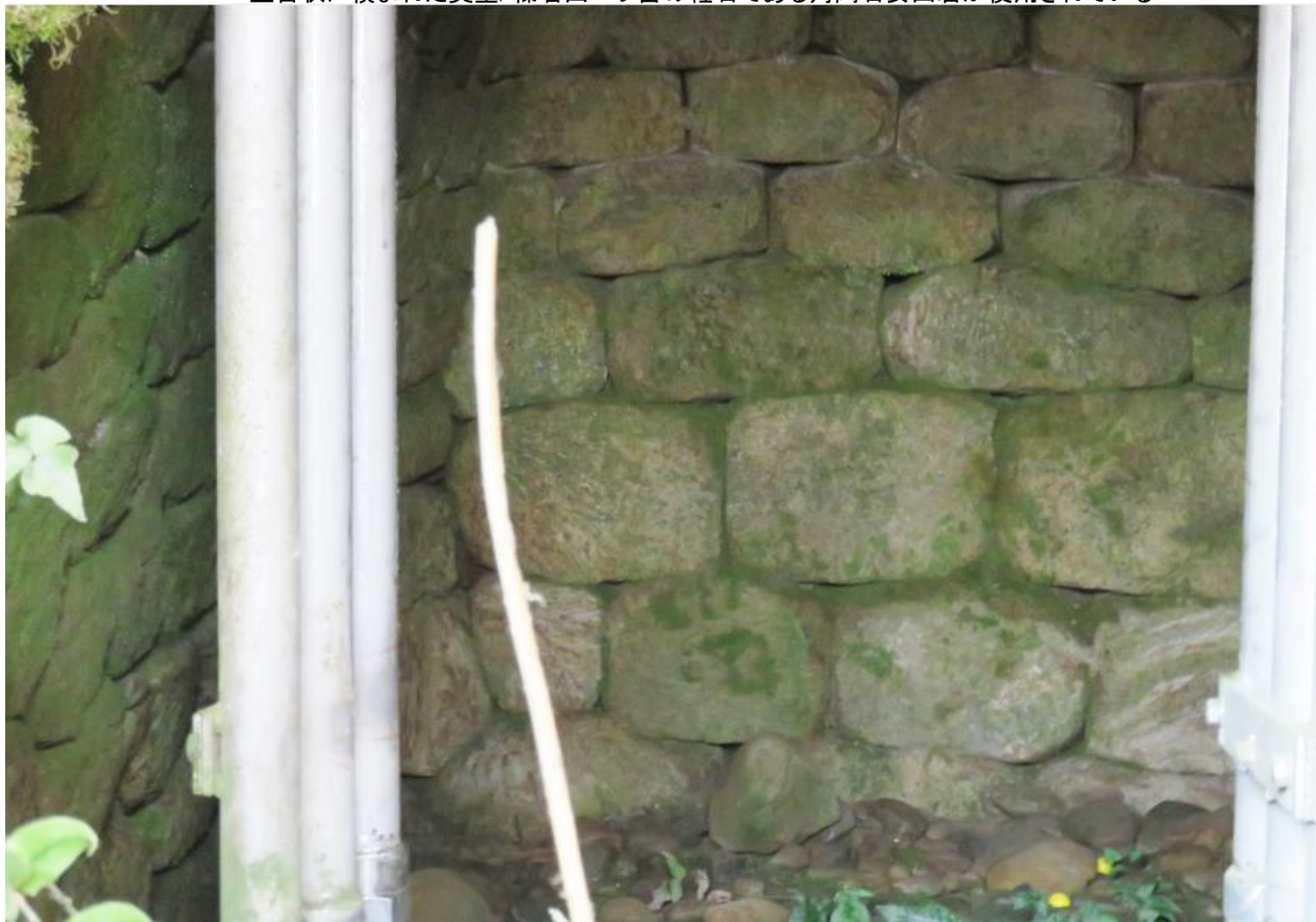
互目状に積まれた奥壁/榛名山ニツ岳の軽石である角閃石安山岩が使用されている
