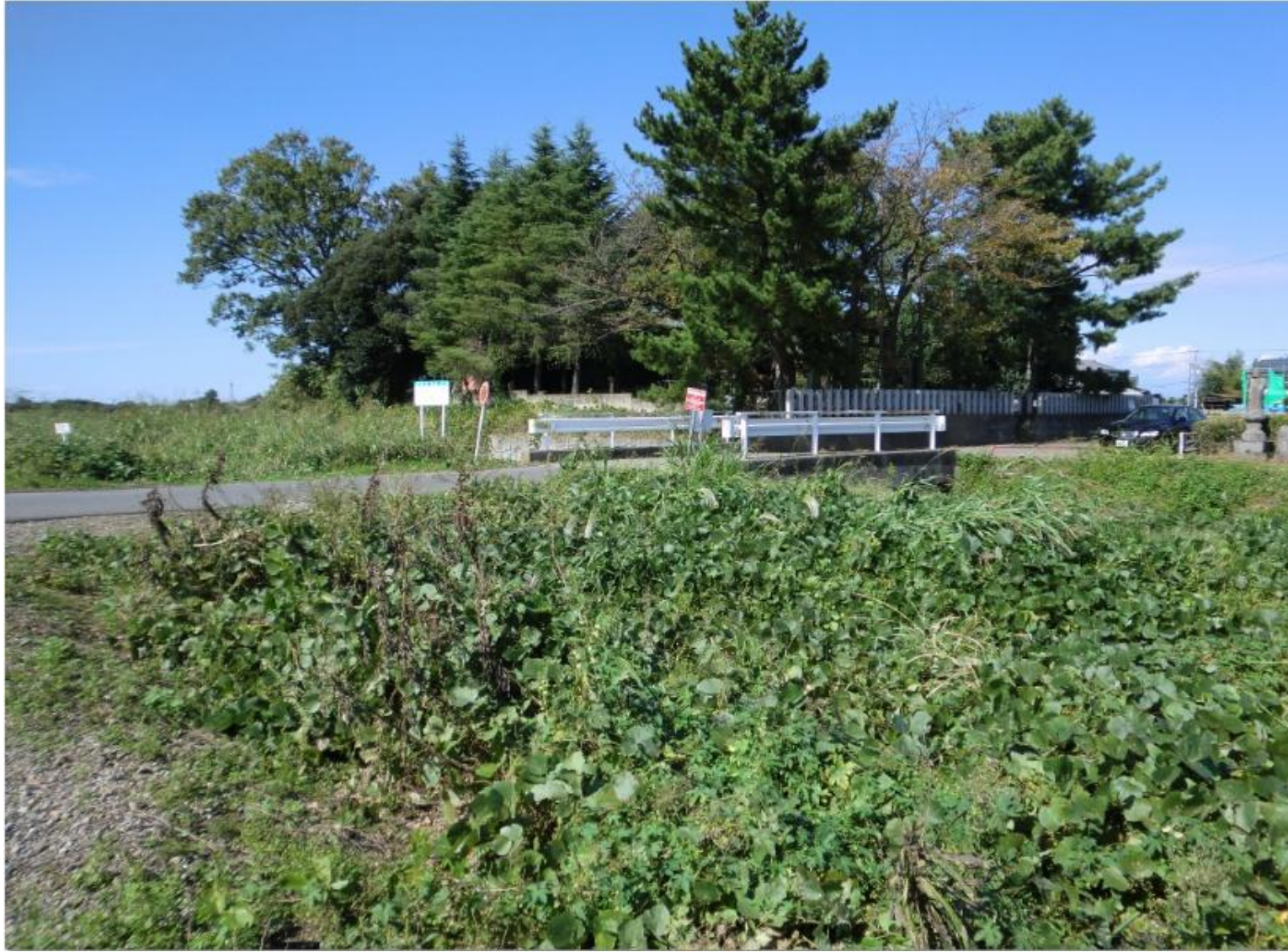
南側から全体を見る
