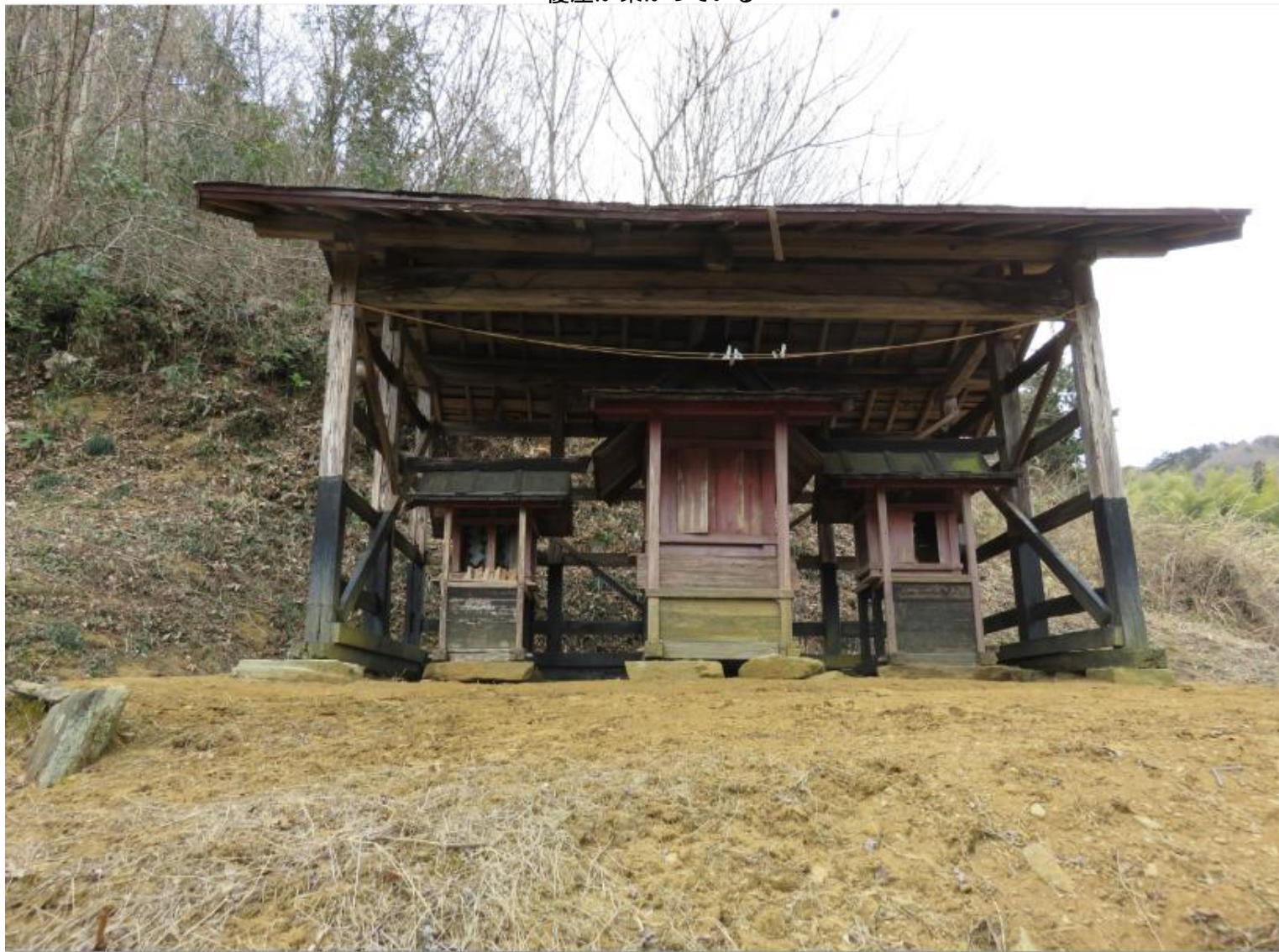
覆屋が架かっている
