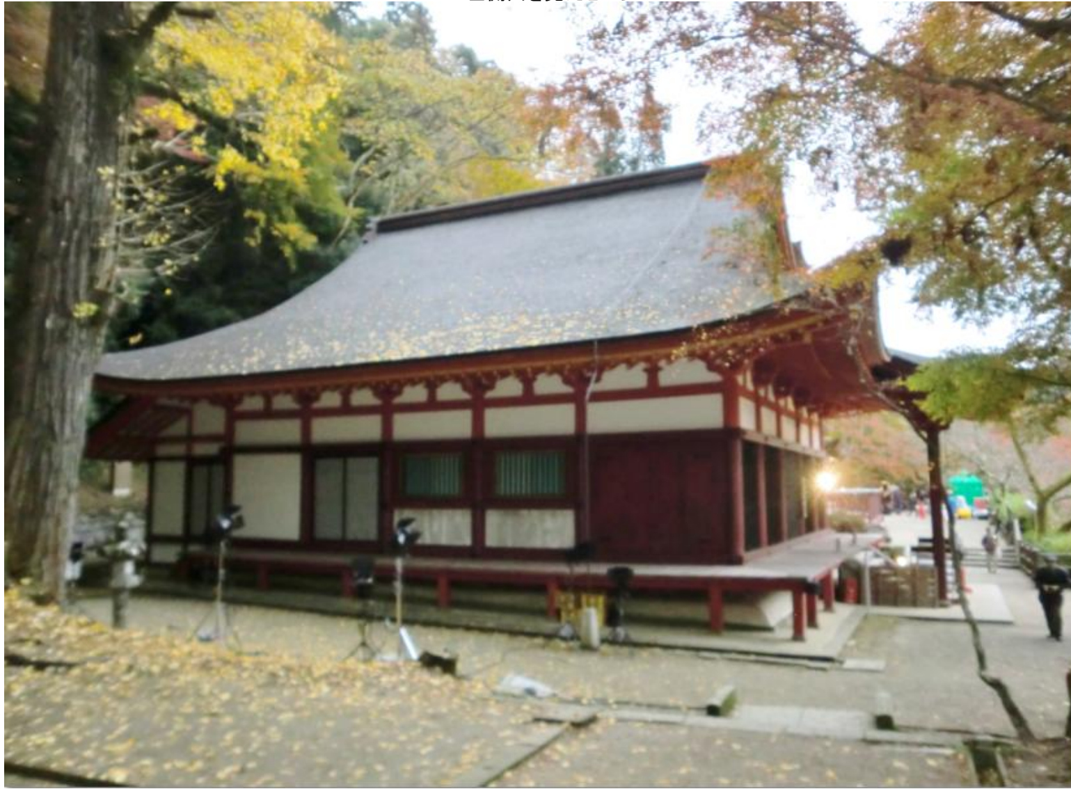
左側面を見たところ
