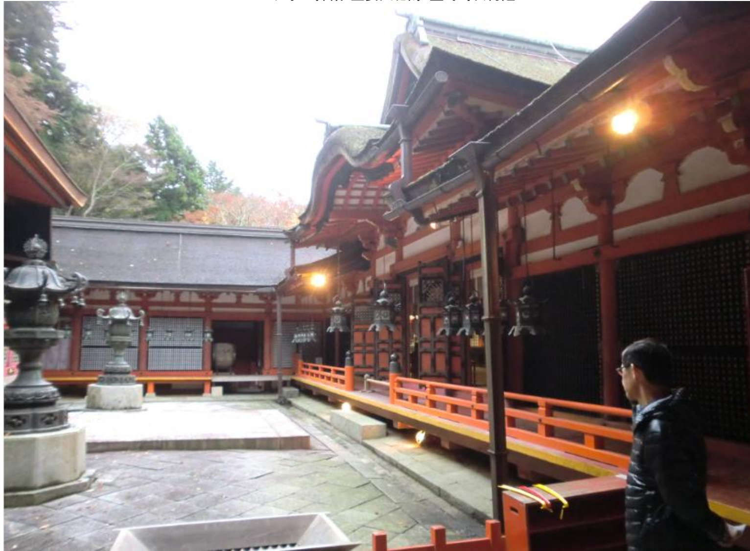
右手の拝殿/重要文化財/室町時代再建
