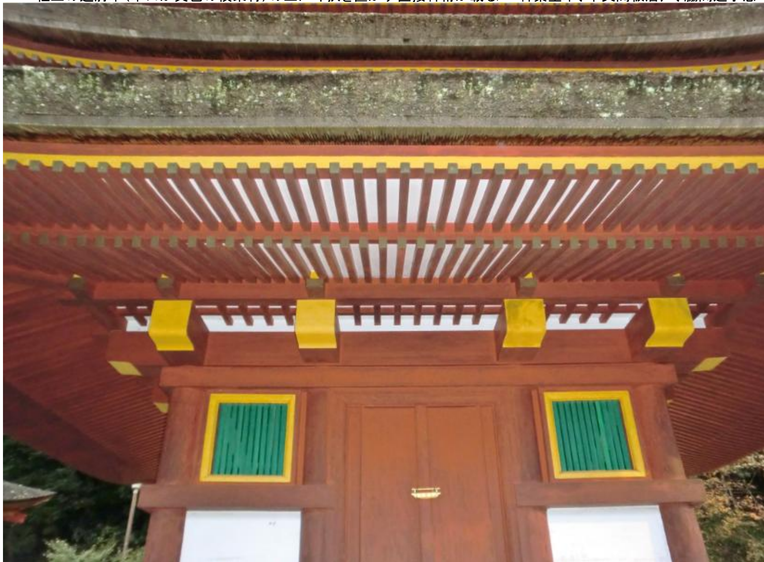
柱上の通肘木(木口が黄色の横架材)の上に斗拱を置かず直接軒桁が載る/二軒繁垂木、中央間板唐戸、脇間連子窓
