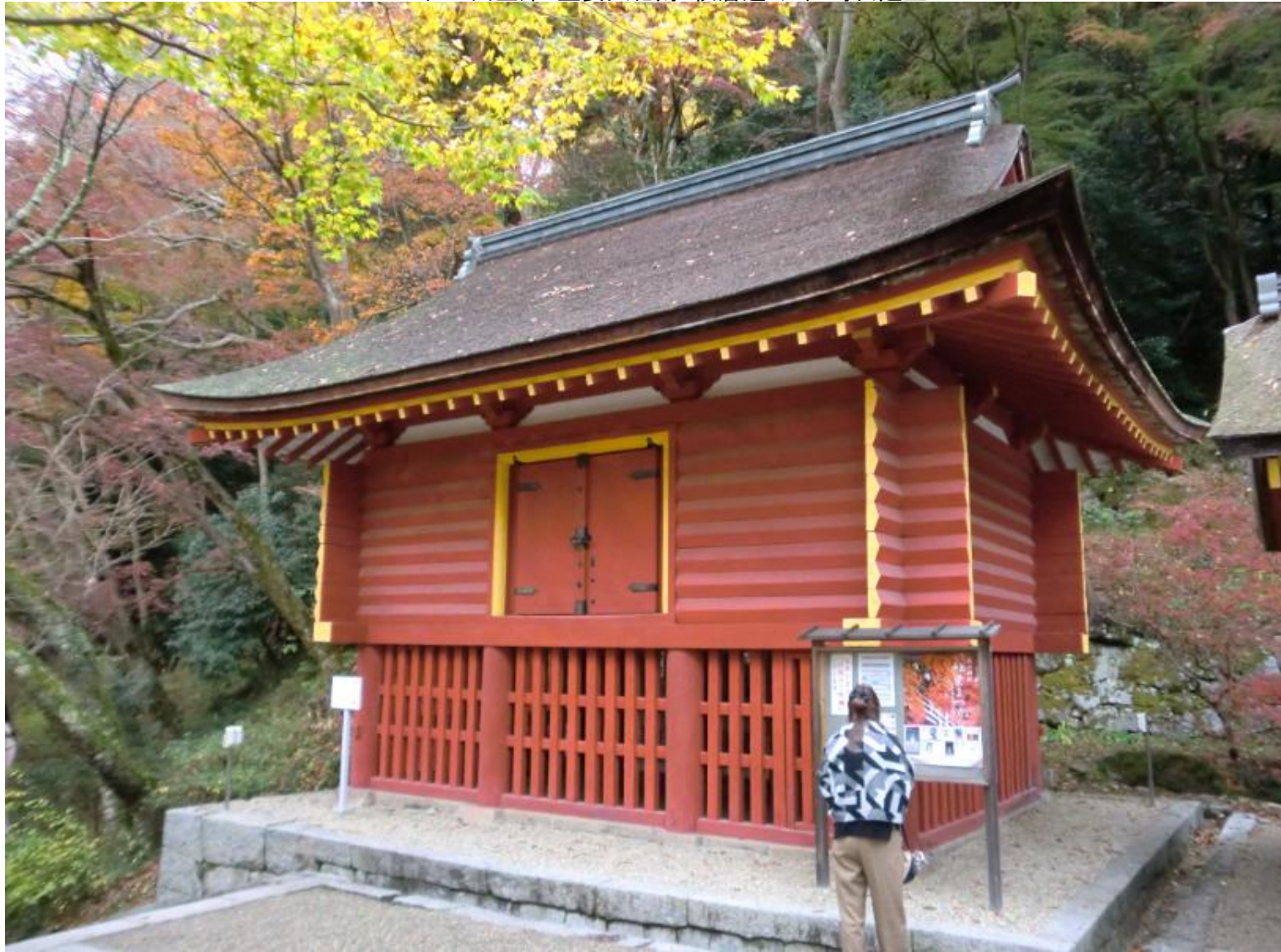
これが西宝庫/重要文化財/校倉造/江戸時代建立
