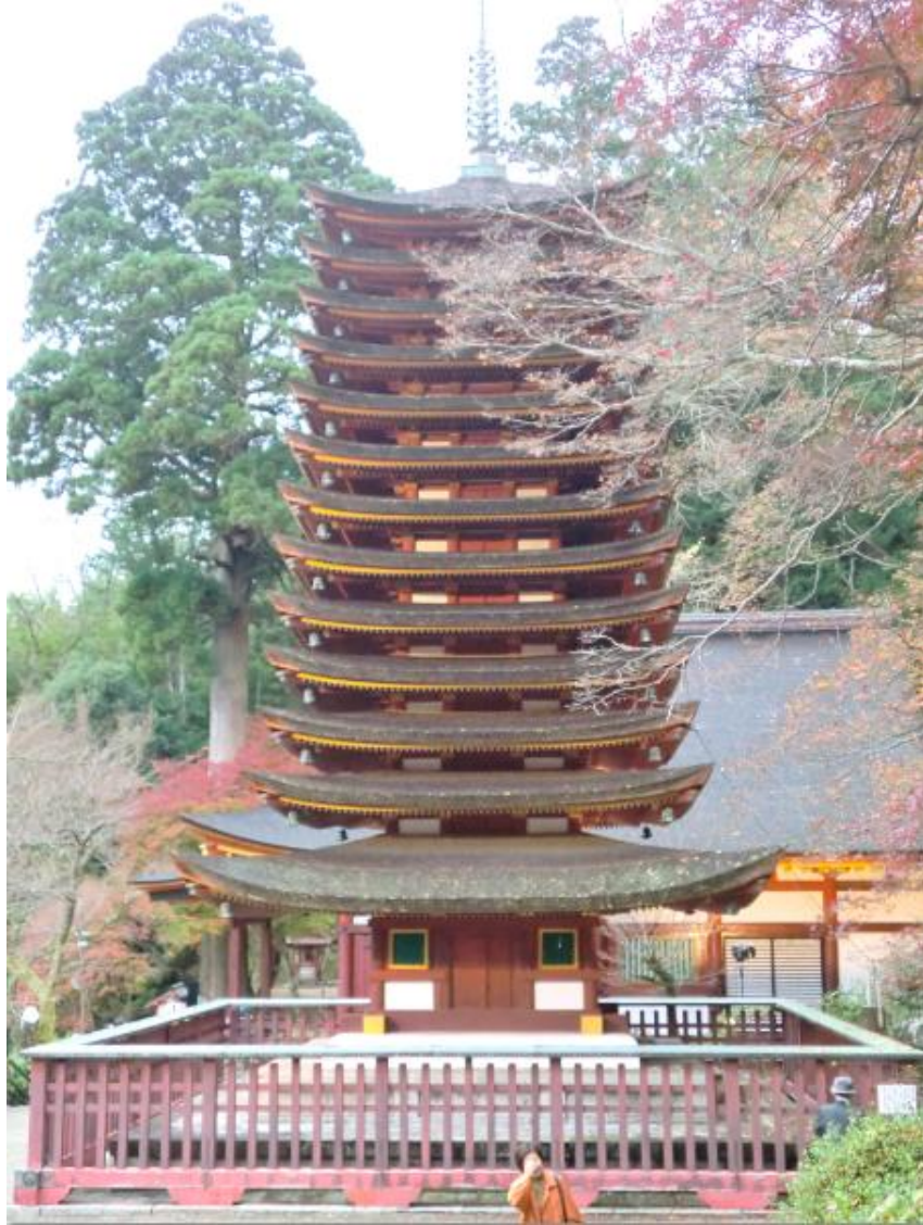
重要文化財/室町時代(1532年)再建/桧皮葺/高さ16.17m/簷塔形式
