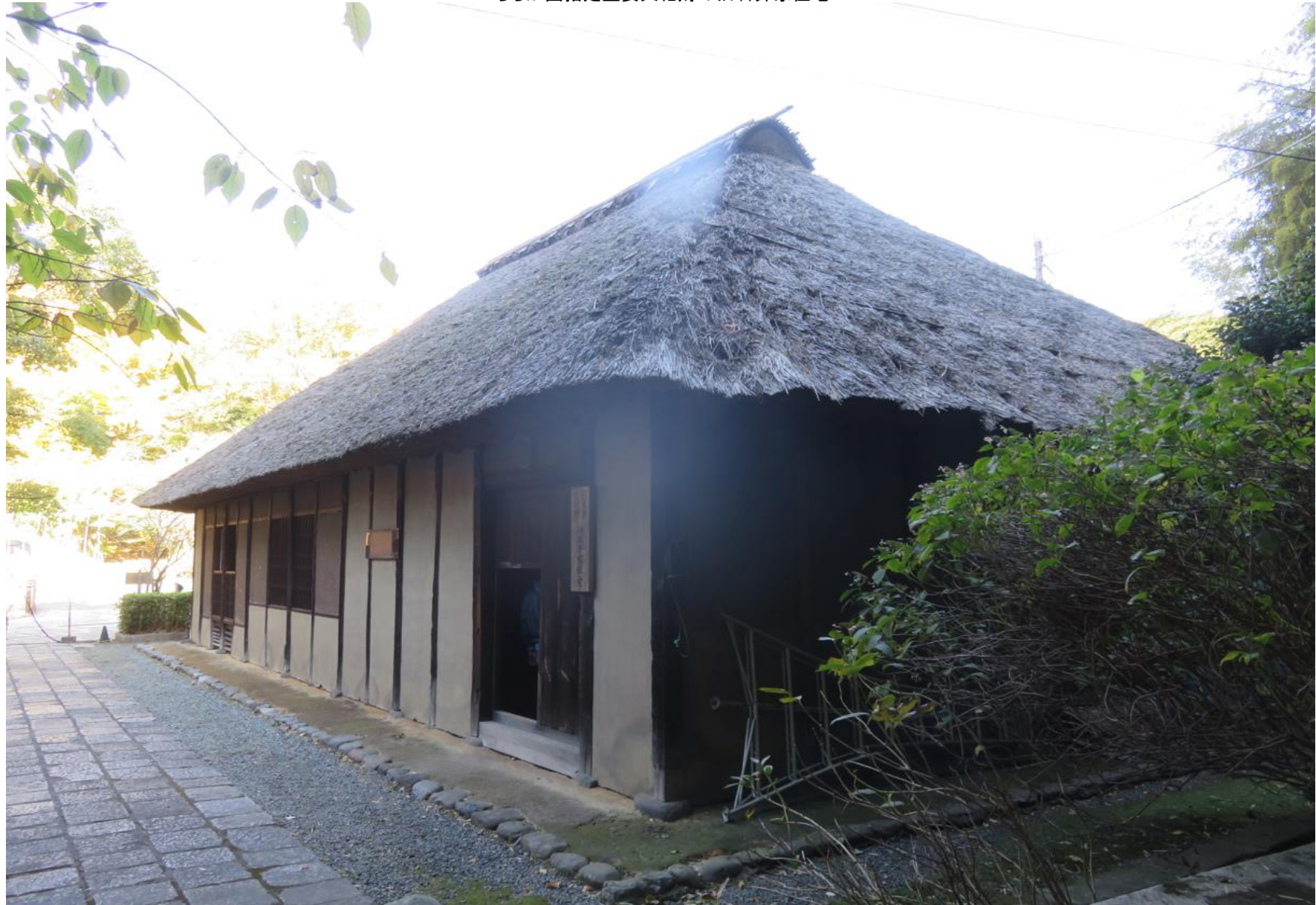
こちらが国指定重要文化財の旧石井家住宅
