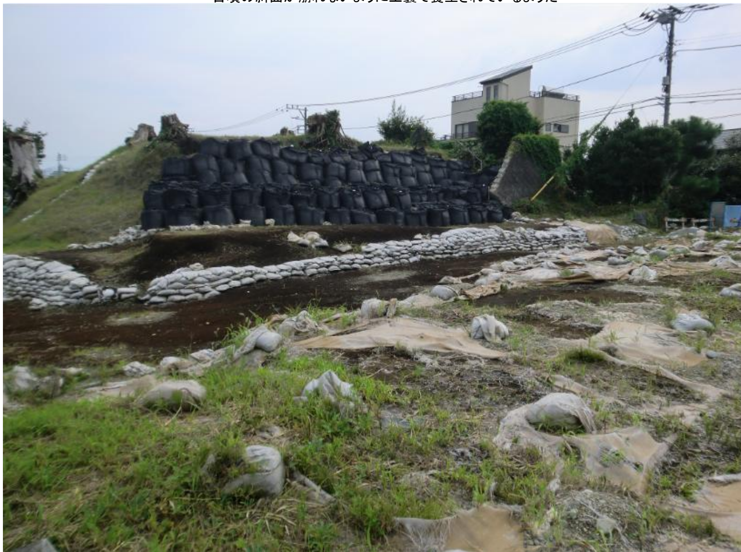
古墳の斜面が崩れないように土嚢で養生されているようだ
