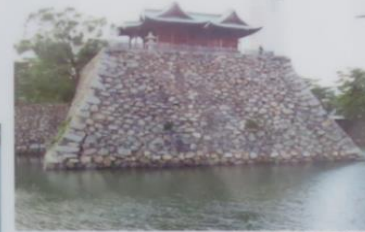
解体する前の玉藻廟
