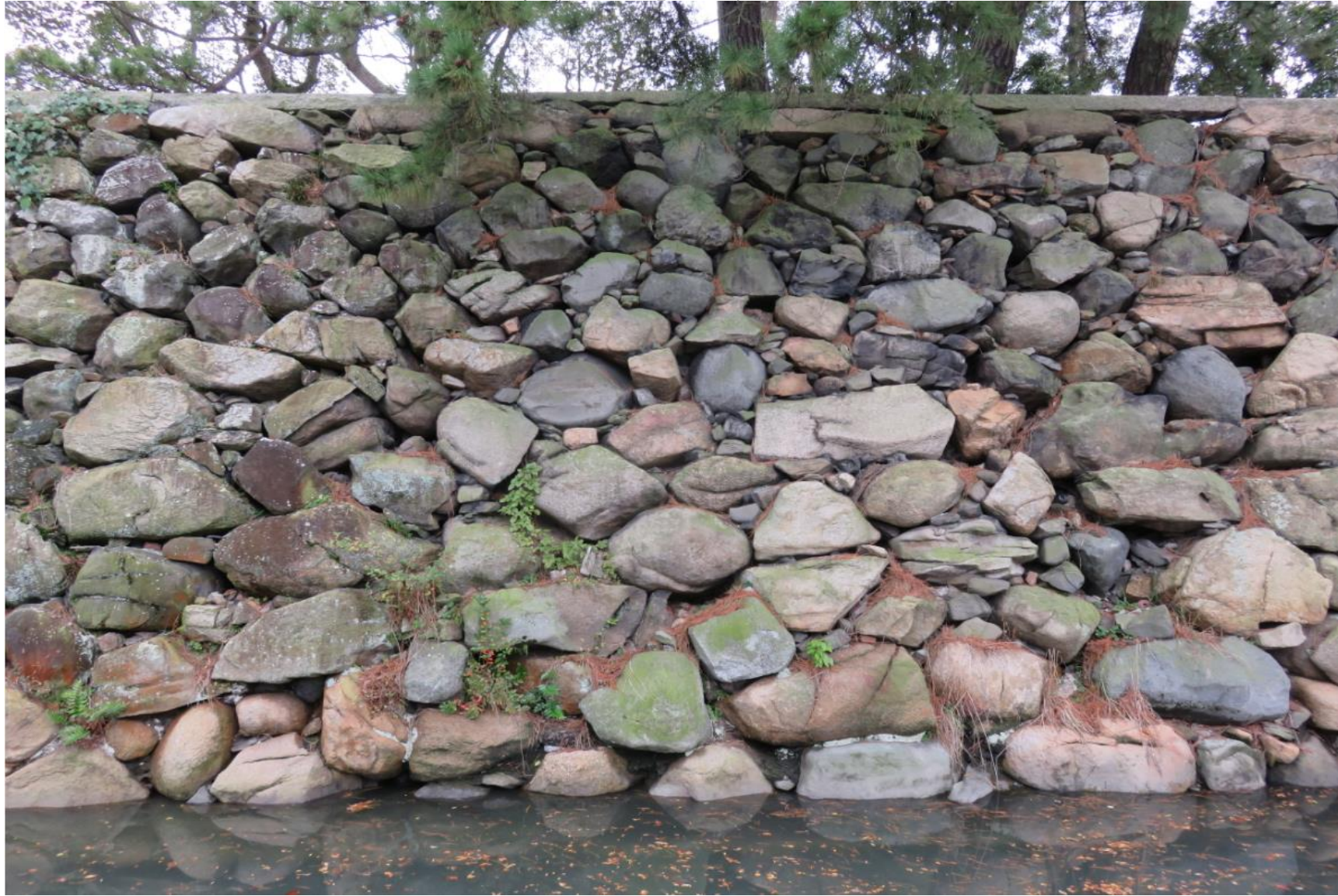
野面積みの石垣をアップで見たところ
