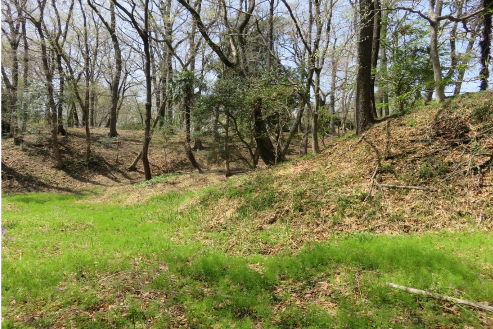
右手に回り込んで見たところ/前方上部は二ノ郭の東側のエリア
