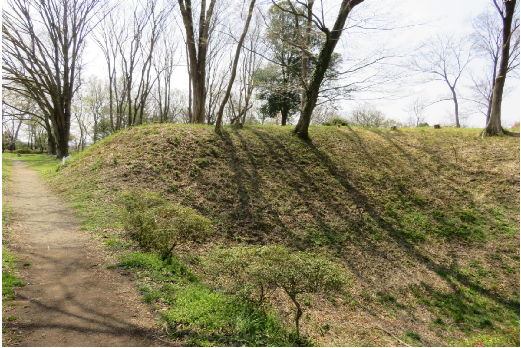
右手の土塁を見たところ
