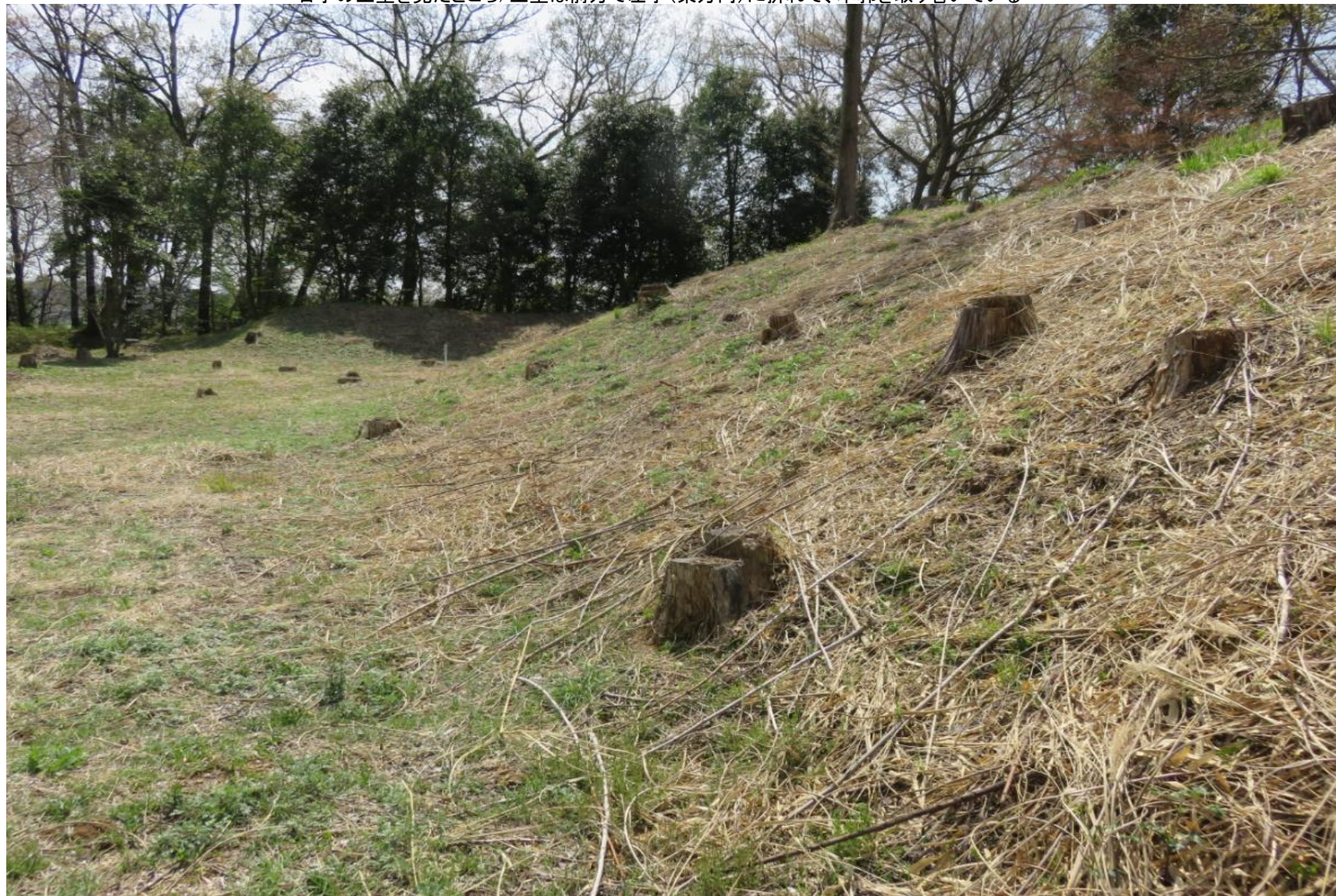
右手の土塁を見たところ/土塁は前方で左手(東方向)に折れて、本郭を取り巻いている
