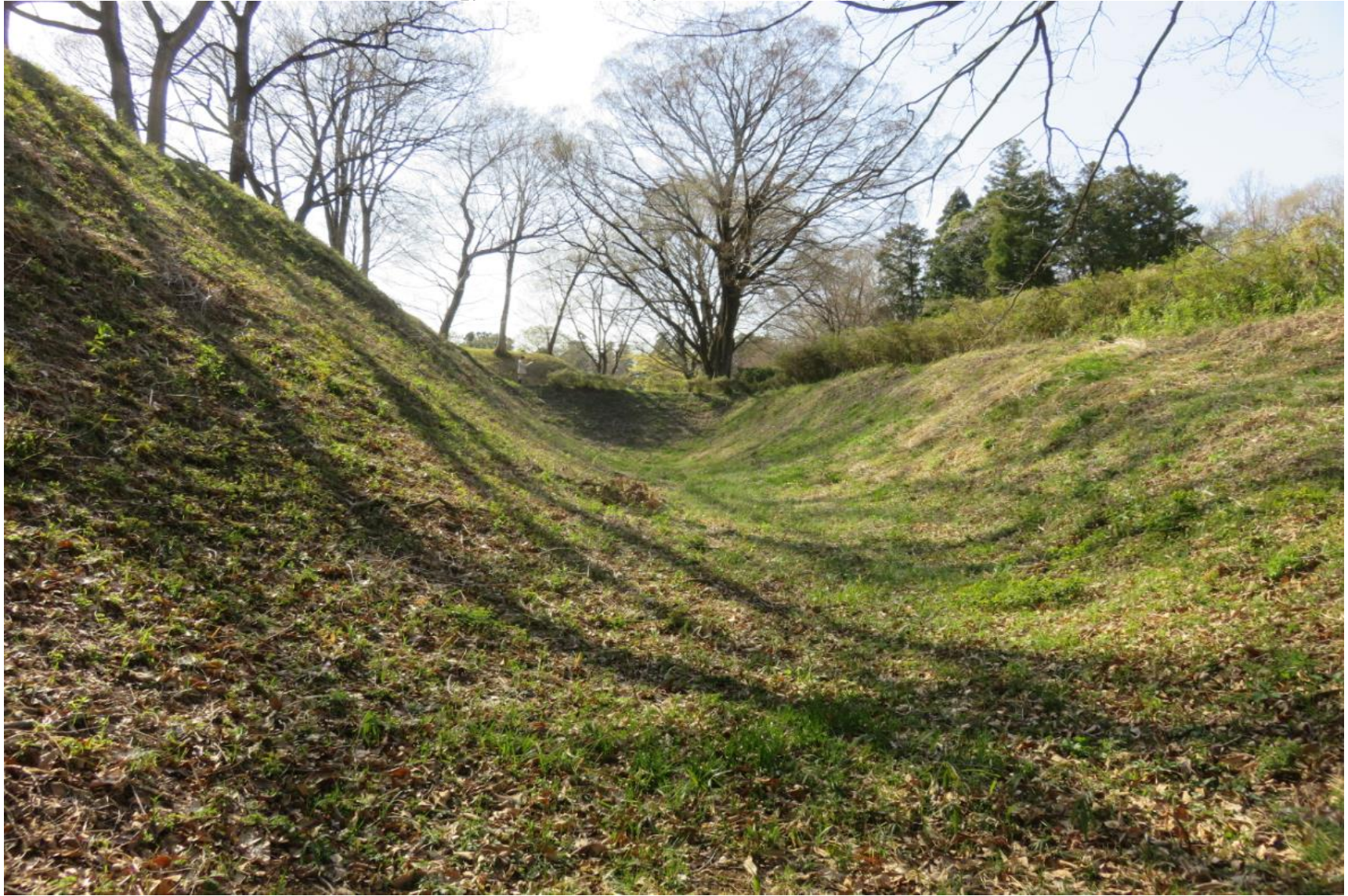
右手(西方向)を見たところ/左手が本郭の土塁/右手は二ノ郭の東側のエリア
