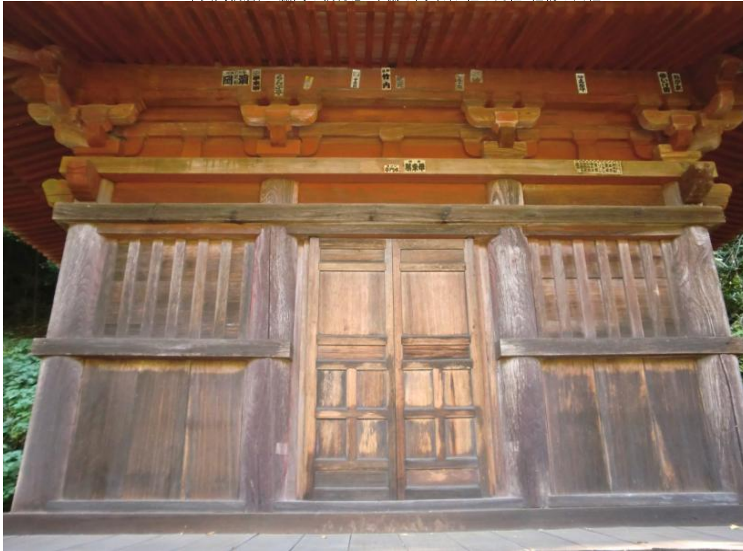
中央間棧唐戸/脇間は棧付窓/中備は間斗束/柱は円柱/組物は出組
