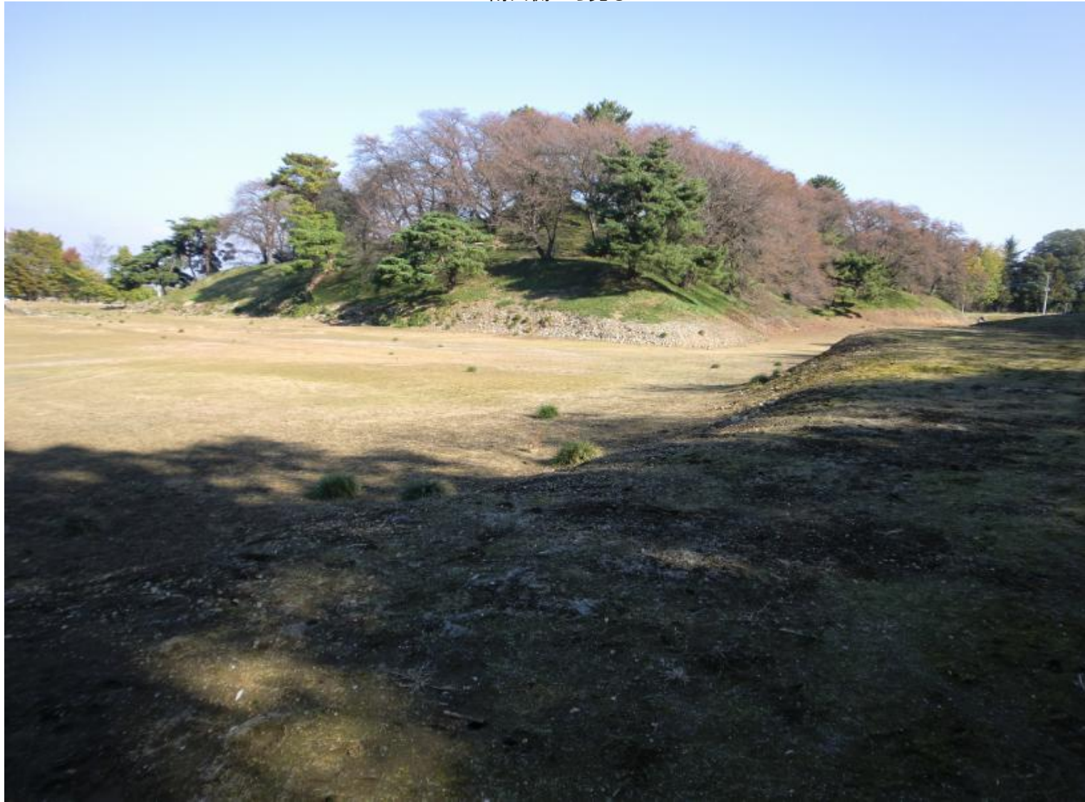
南西側から見る
