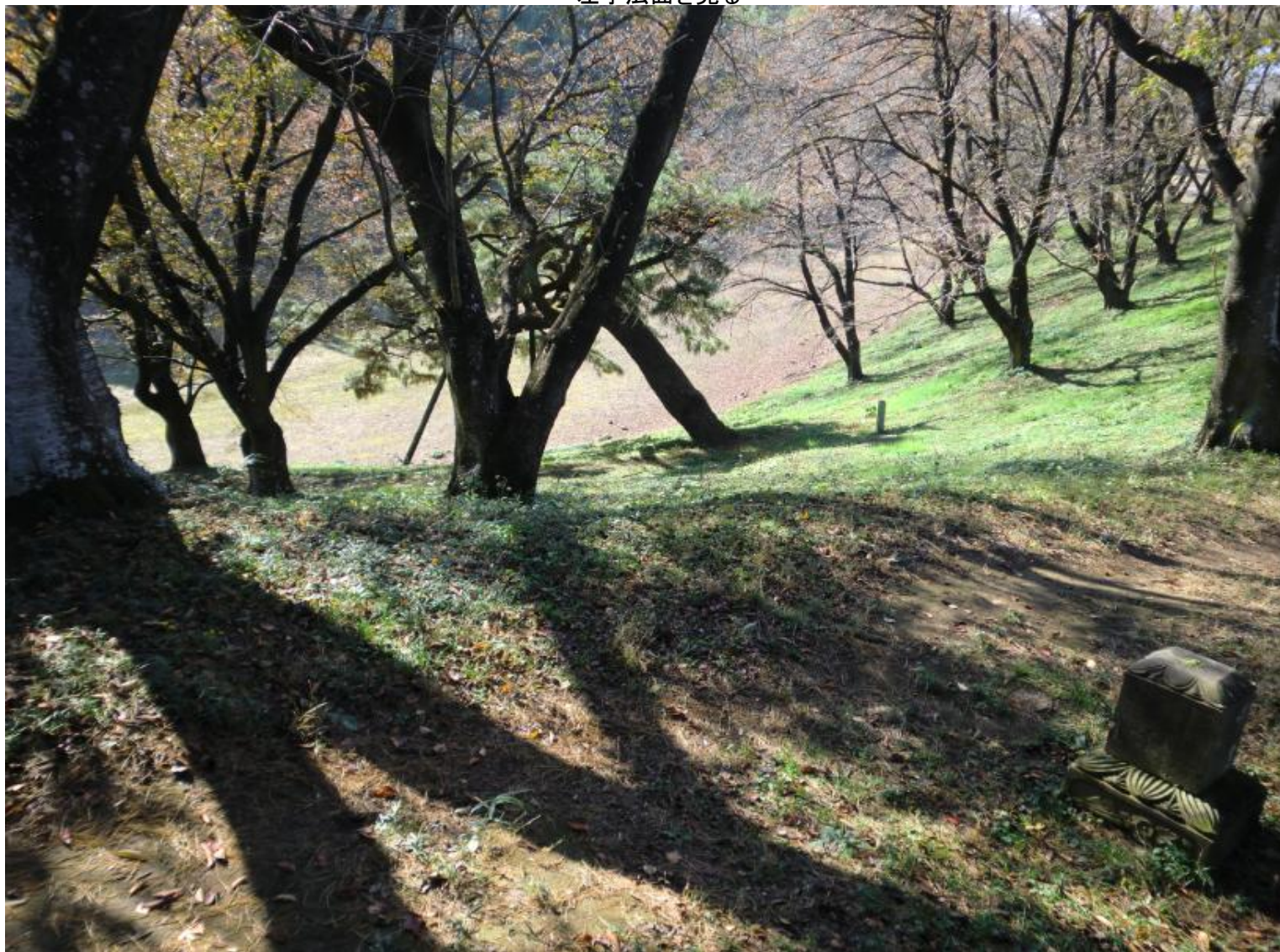
左手法面を見る
