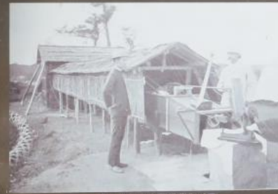
据えられた水平望遠カメラ
