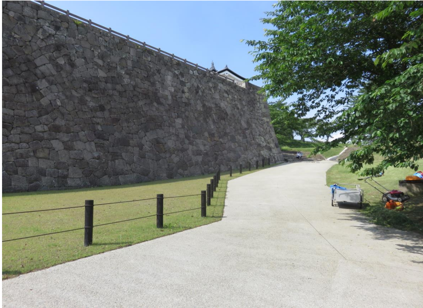
同じく、右手を見たところ/スロープを登った先は竹之丸
