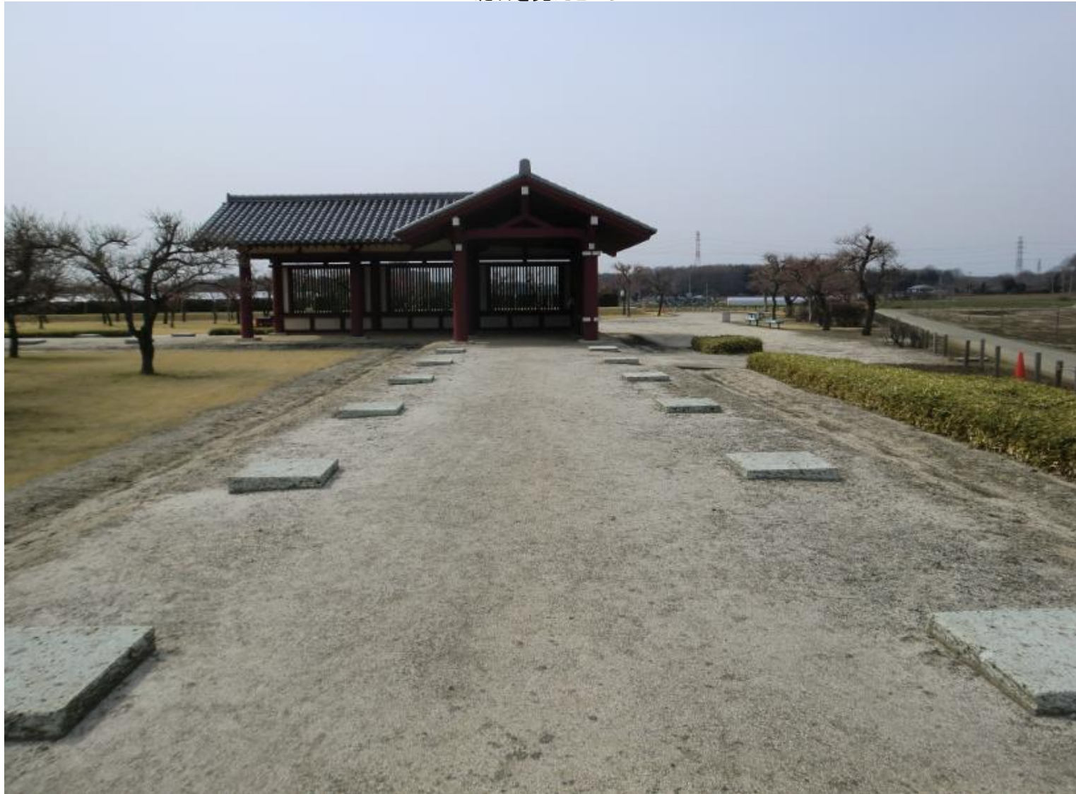
礎石を見たところ
