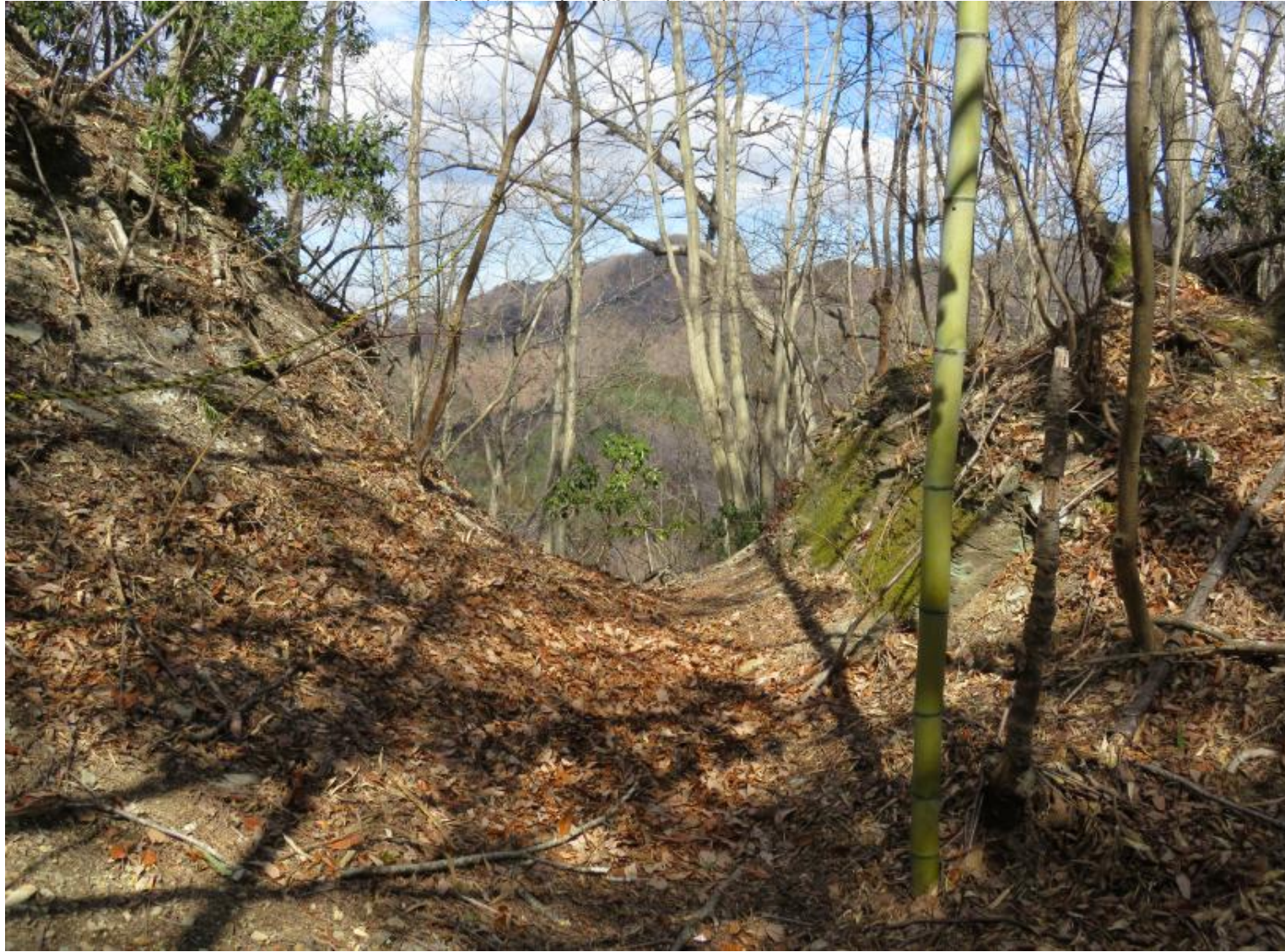
横堀は北東に続く尾根の堀切となっている
