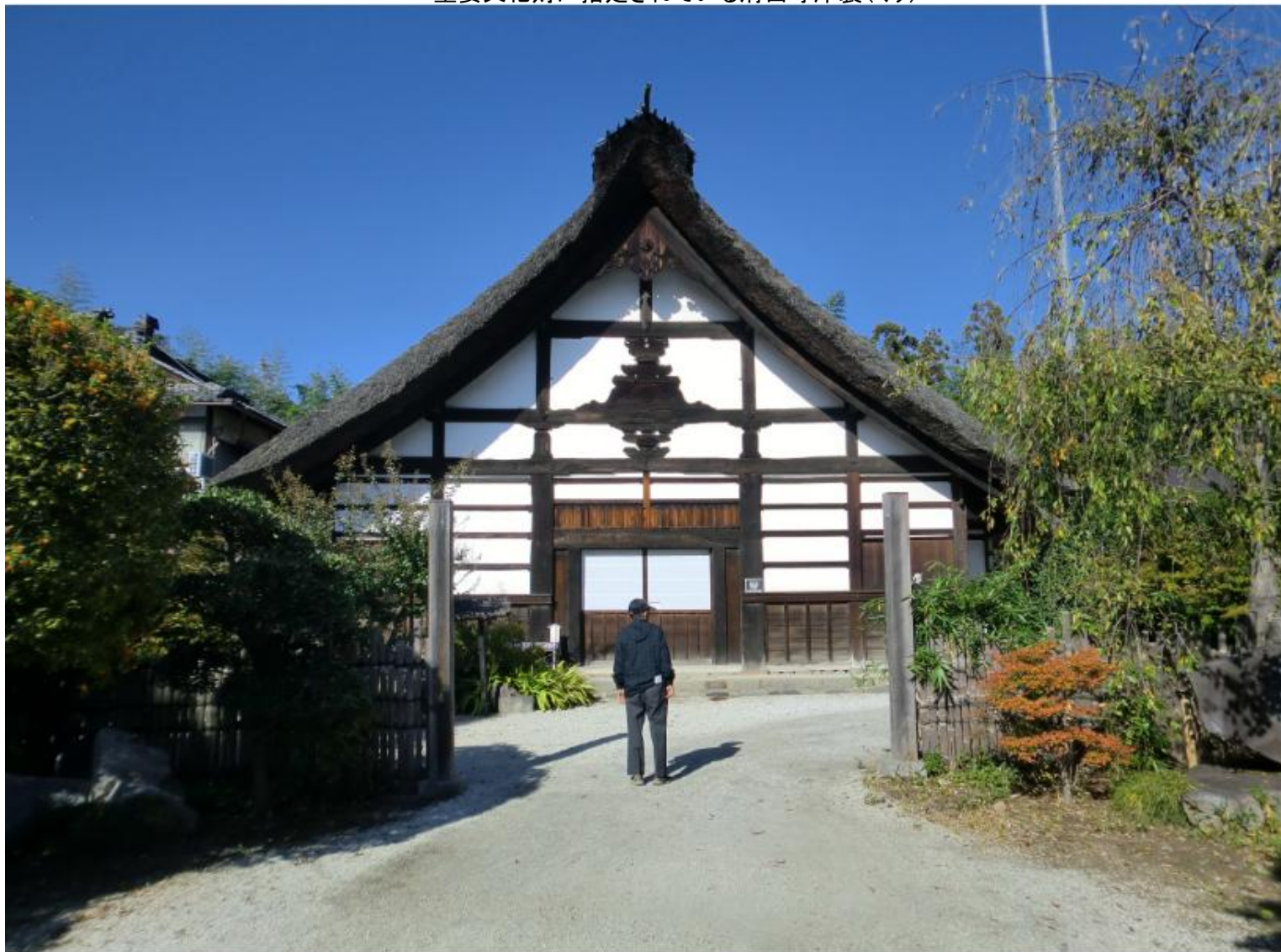
重要文化財に指定されている清白寺庫裏(くり)
