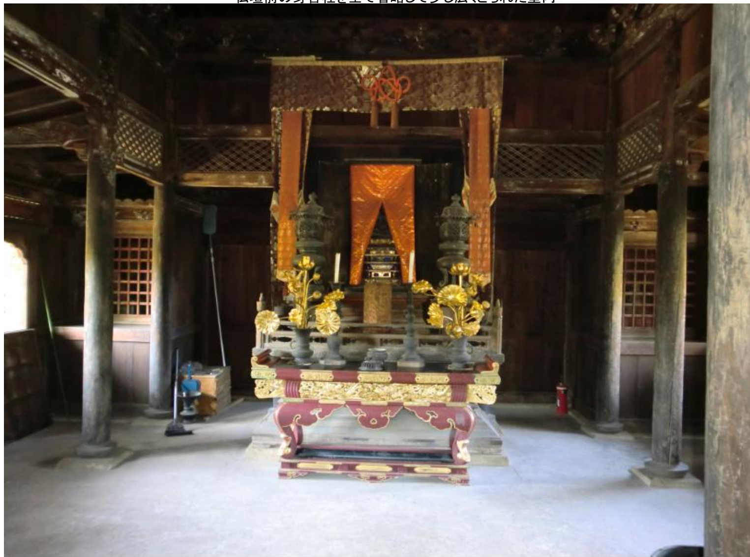
仏壇前の身舎柱を全て省略して少し広くとられた堂内
