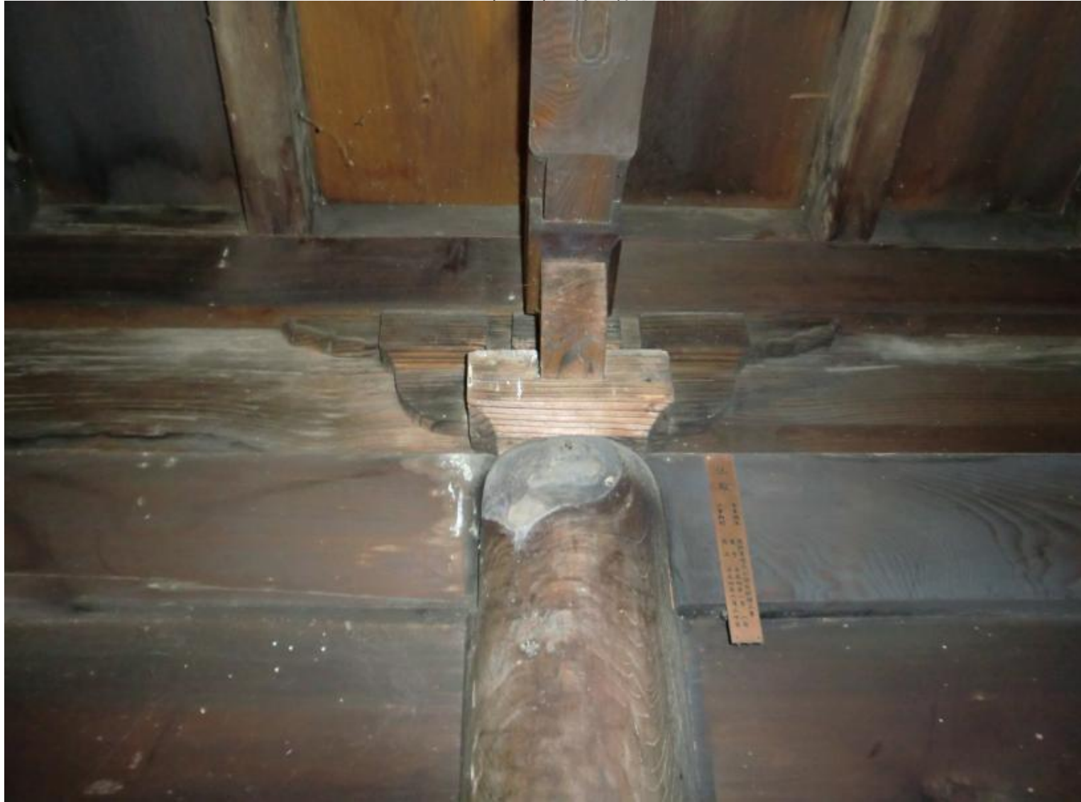
柱上部の粽の様子
