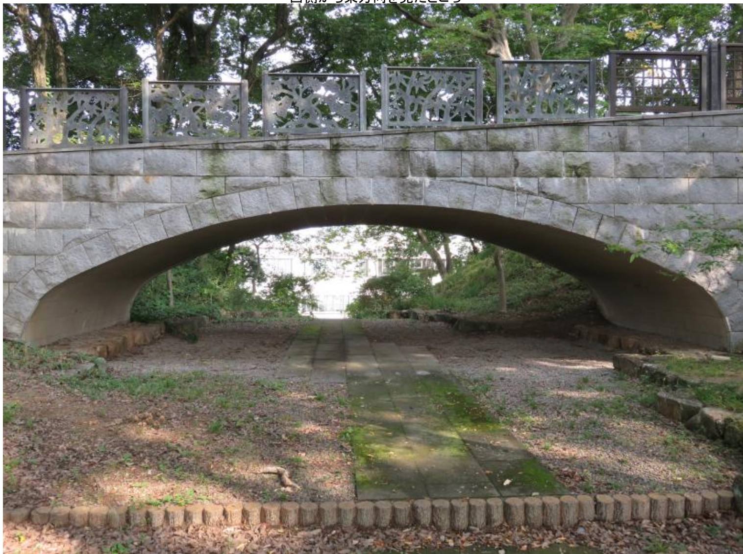
西側から東方向を見たところ
