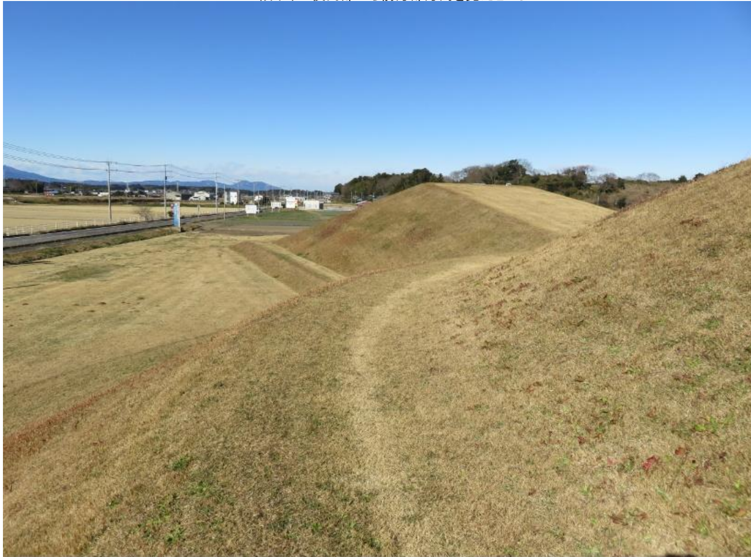
一段下りて後円部から前方部方向を見たところ
