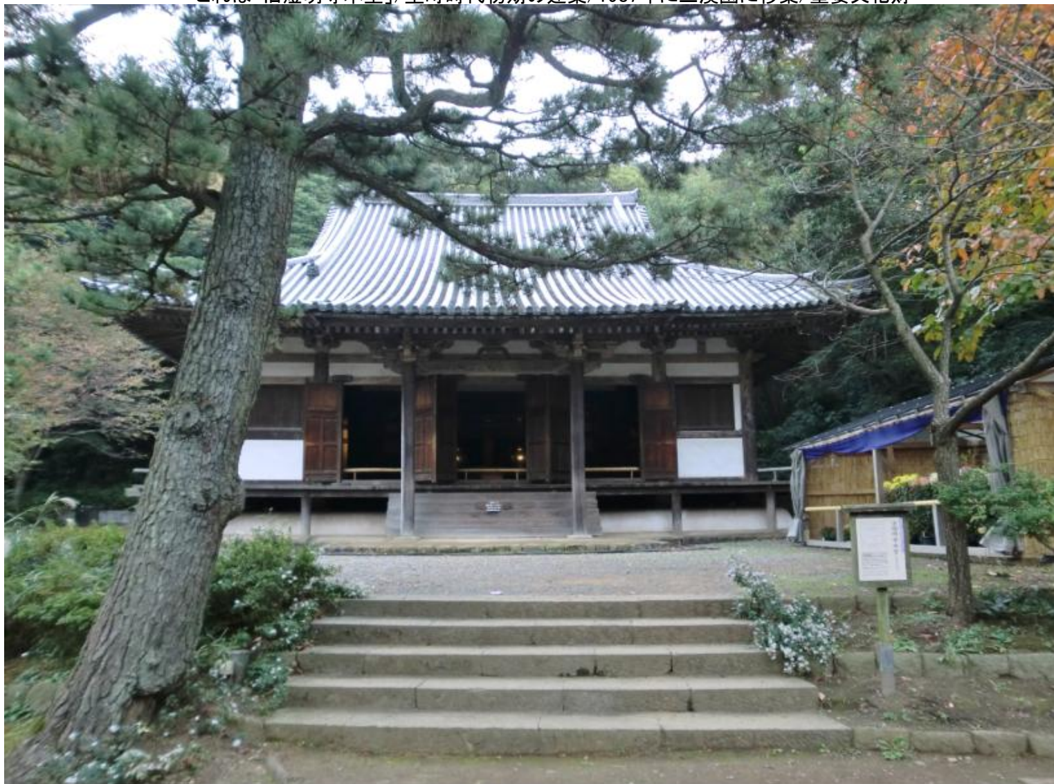
これは「旧燈明寺本堂」/室町時代初期の建築/1987年に三溪園に移築/重要文化財
