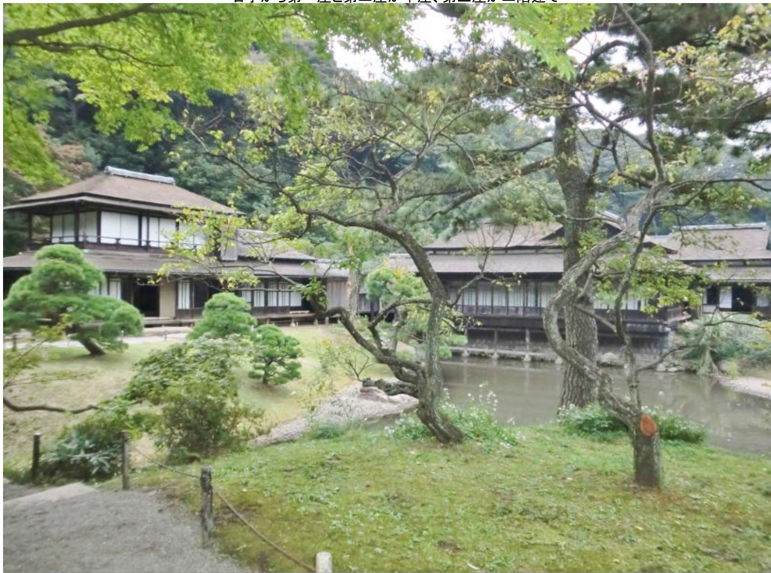
右手から第一屋と第二屋が平屋、第三屋が二階建て
