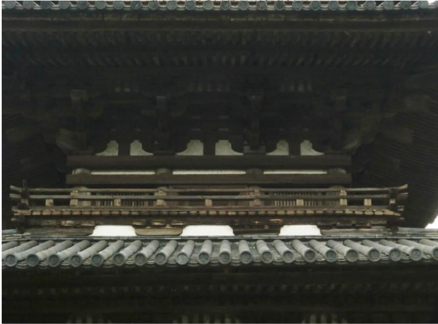
二層部(脇間連子窓、中備えは三間とも間斗束)
