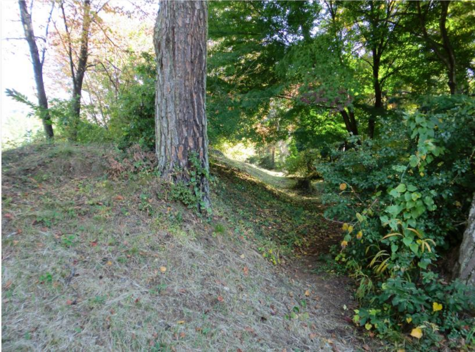
北側の土塁の状況
