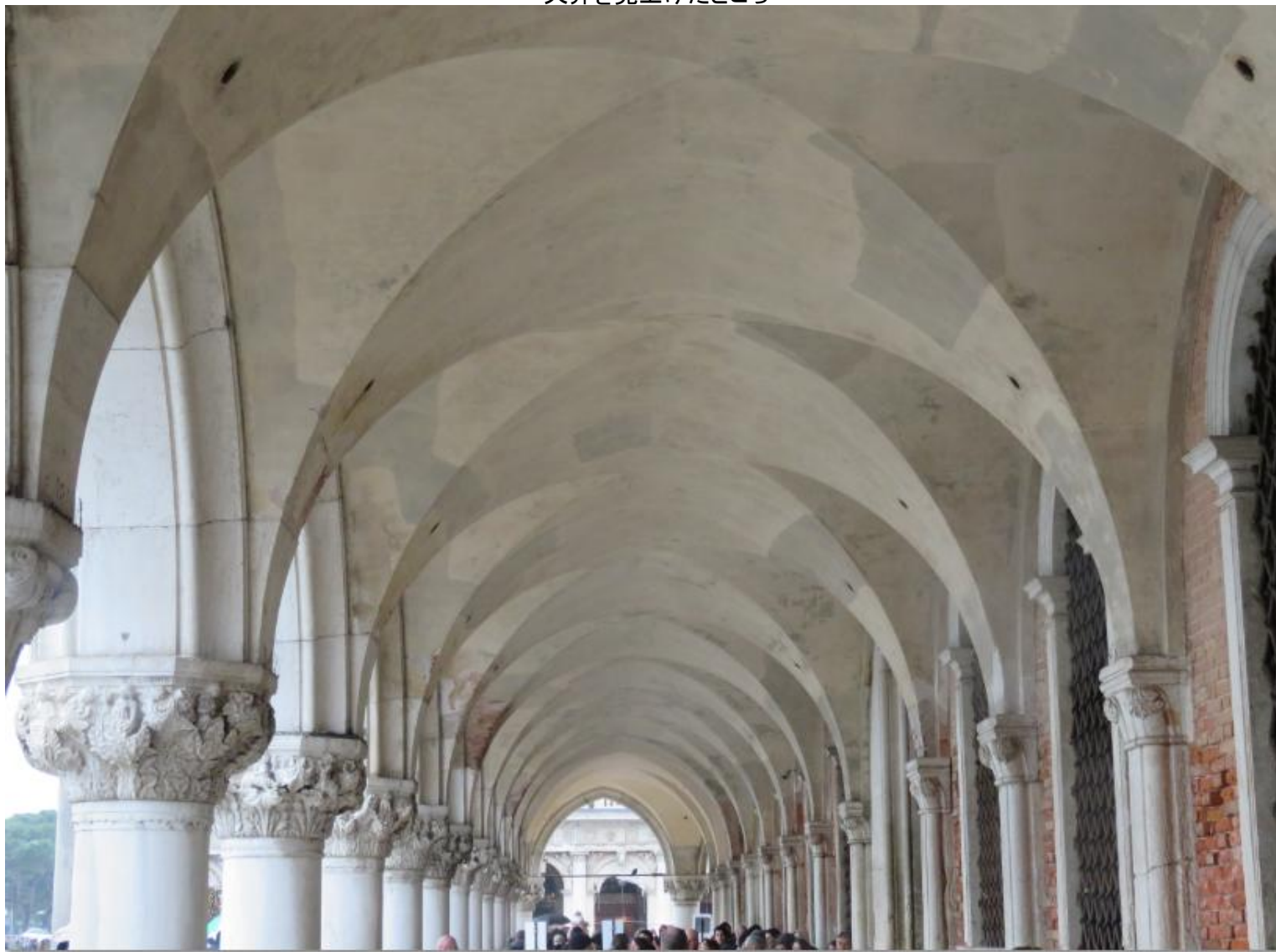
天井を見上げたところ
