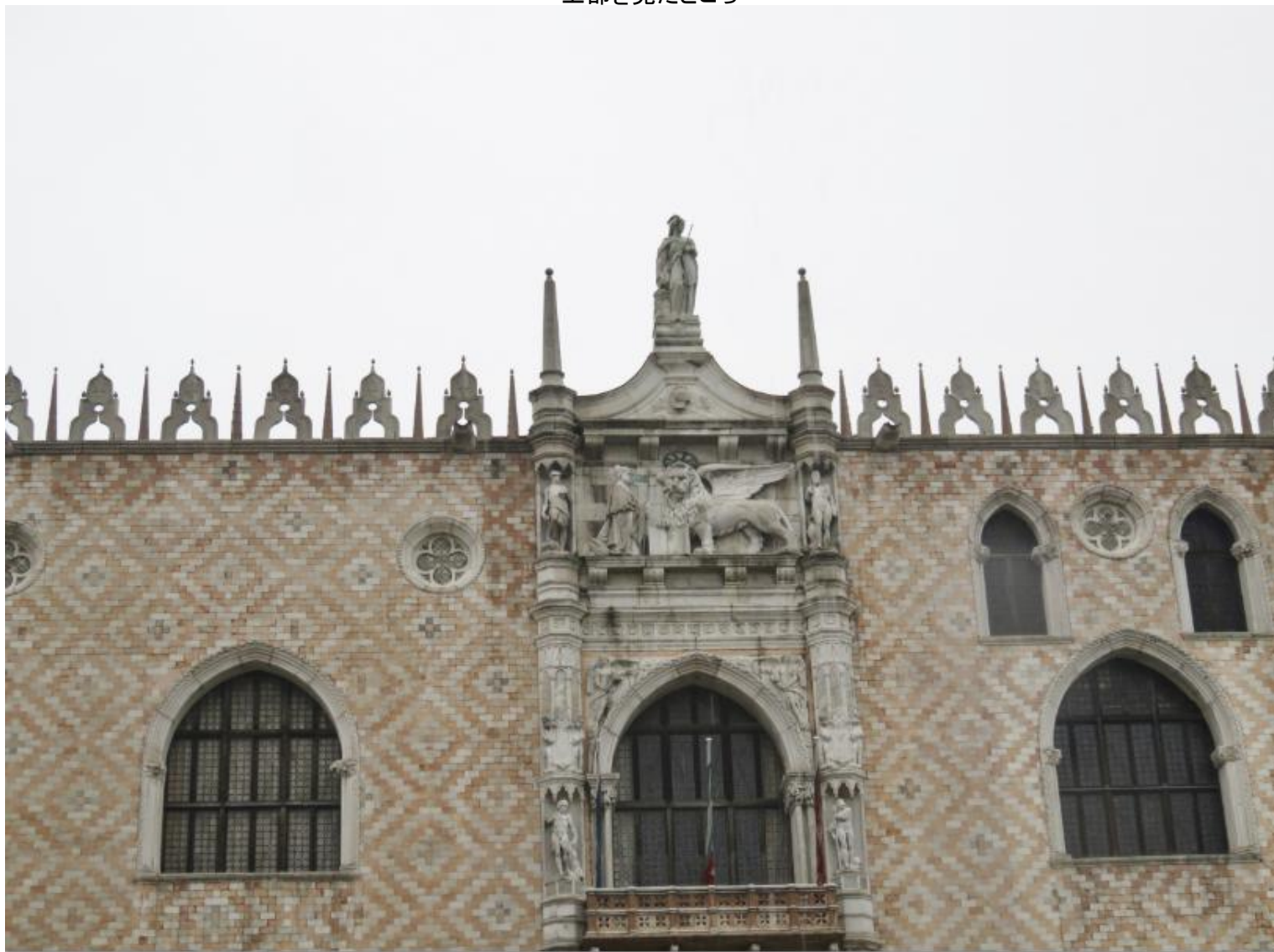
上部を見たところ
