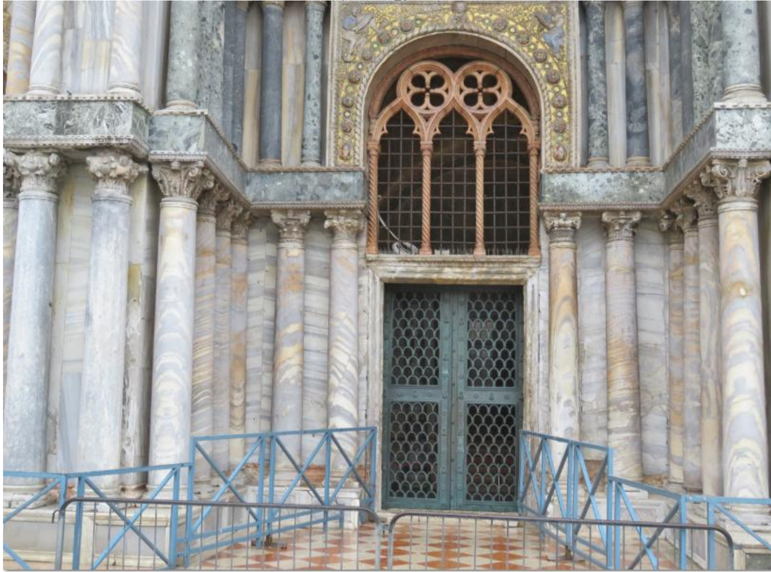
左隣の入口を見たところ
