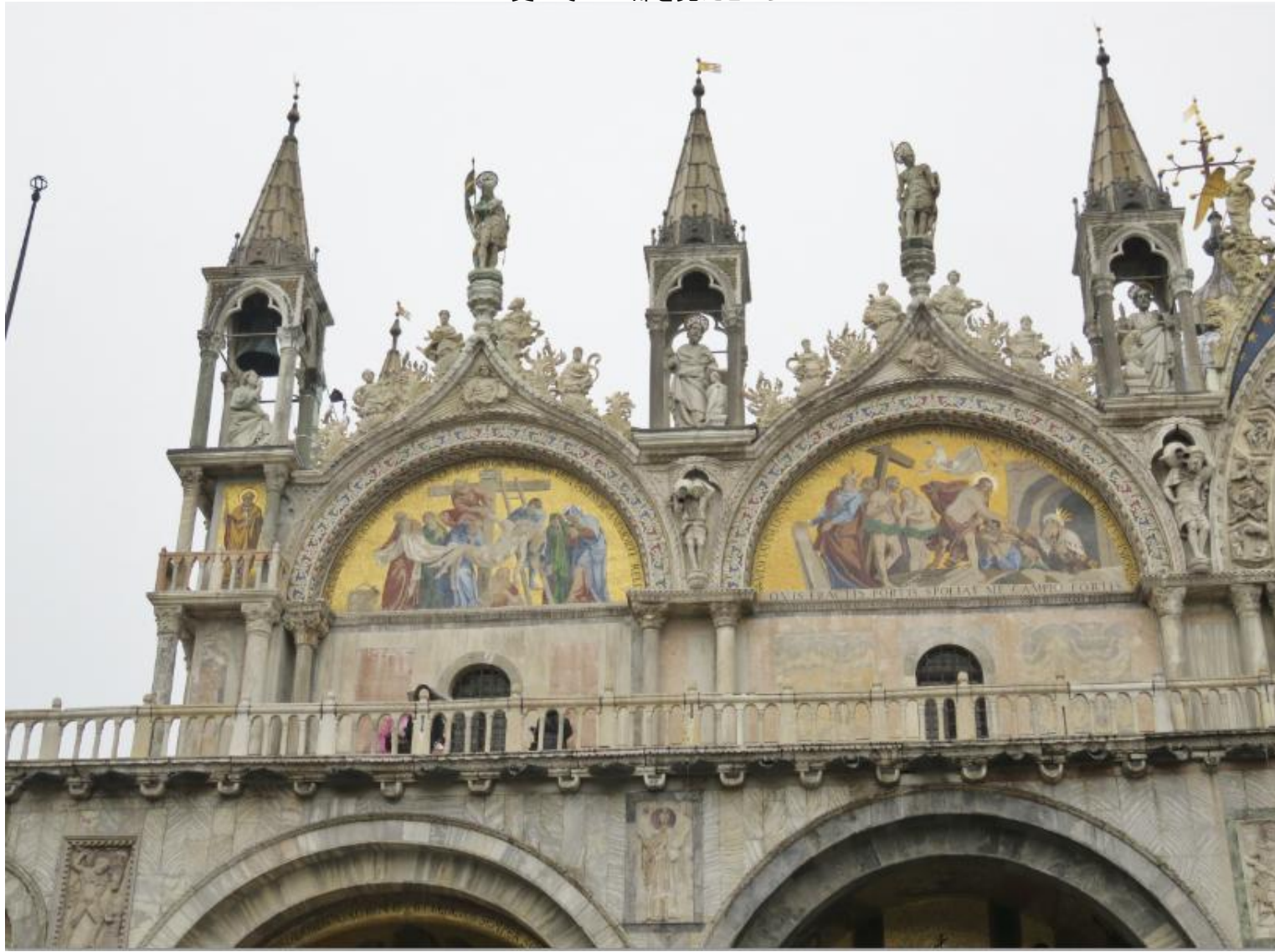
更にその上部を見たところ
