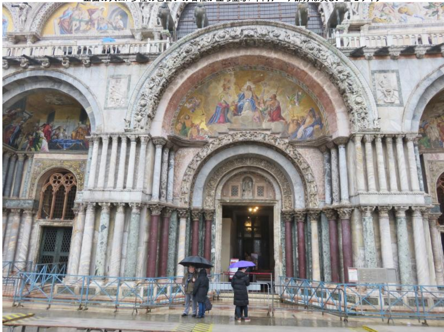
正面の入口/多種の色合いの石柱が立ち並ぶ/半円アーチ部分は美しい金モザイク
