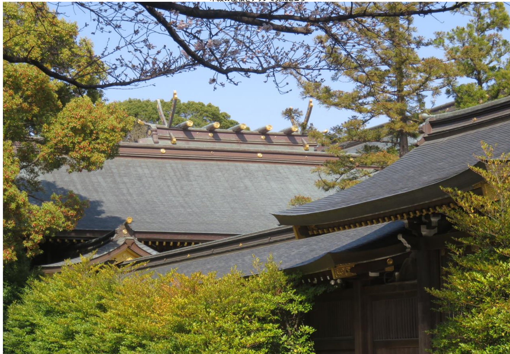
本殿の屋根をアップで見たとこ
