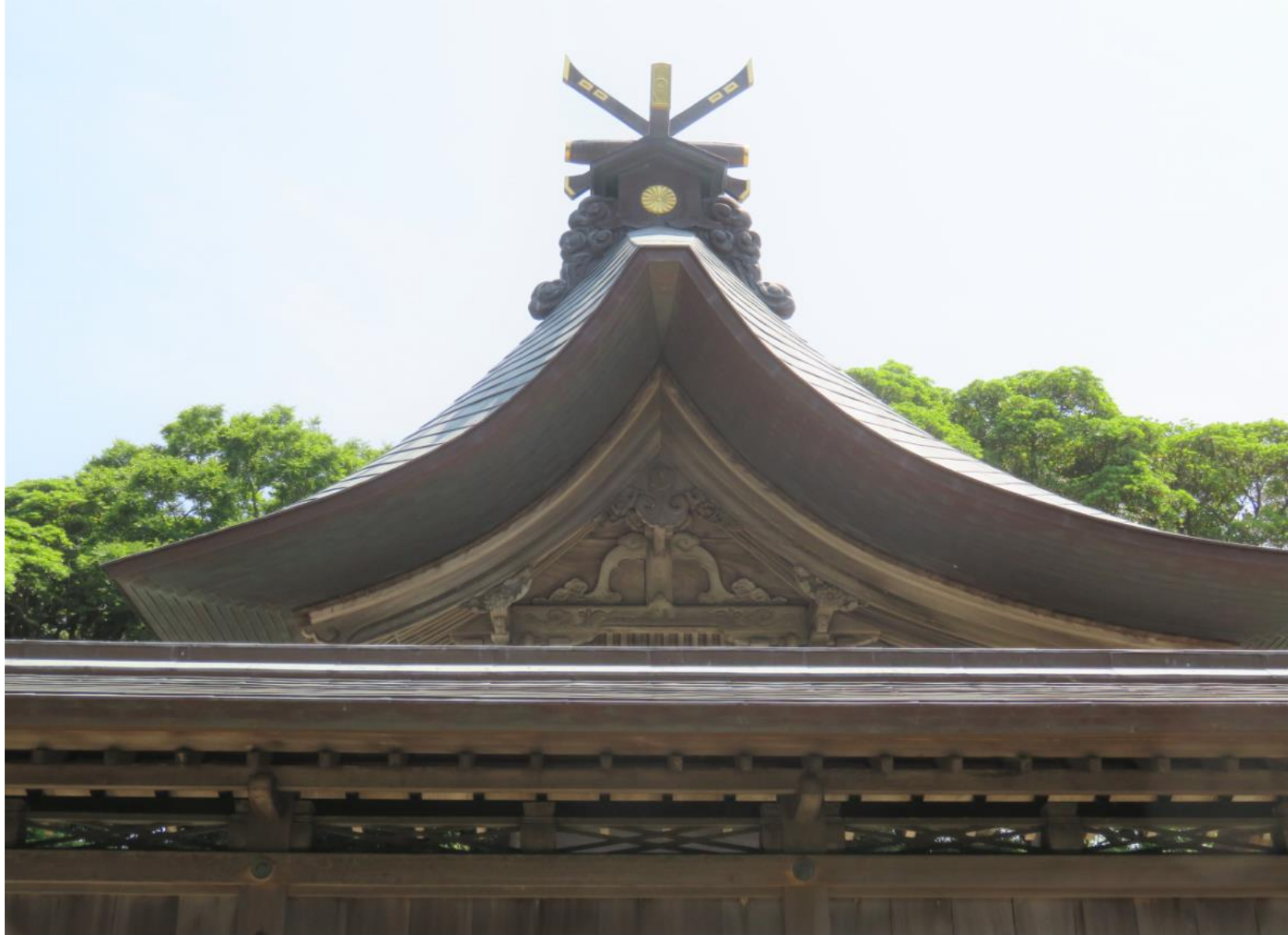
本殿屋根の妻面をアップで見たところ
