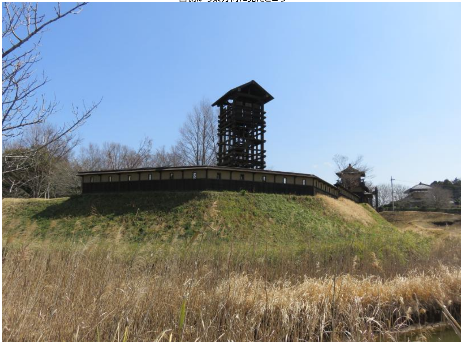
西側から東方向に見たところ
