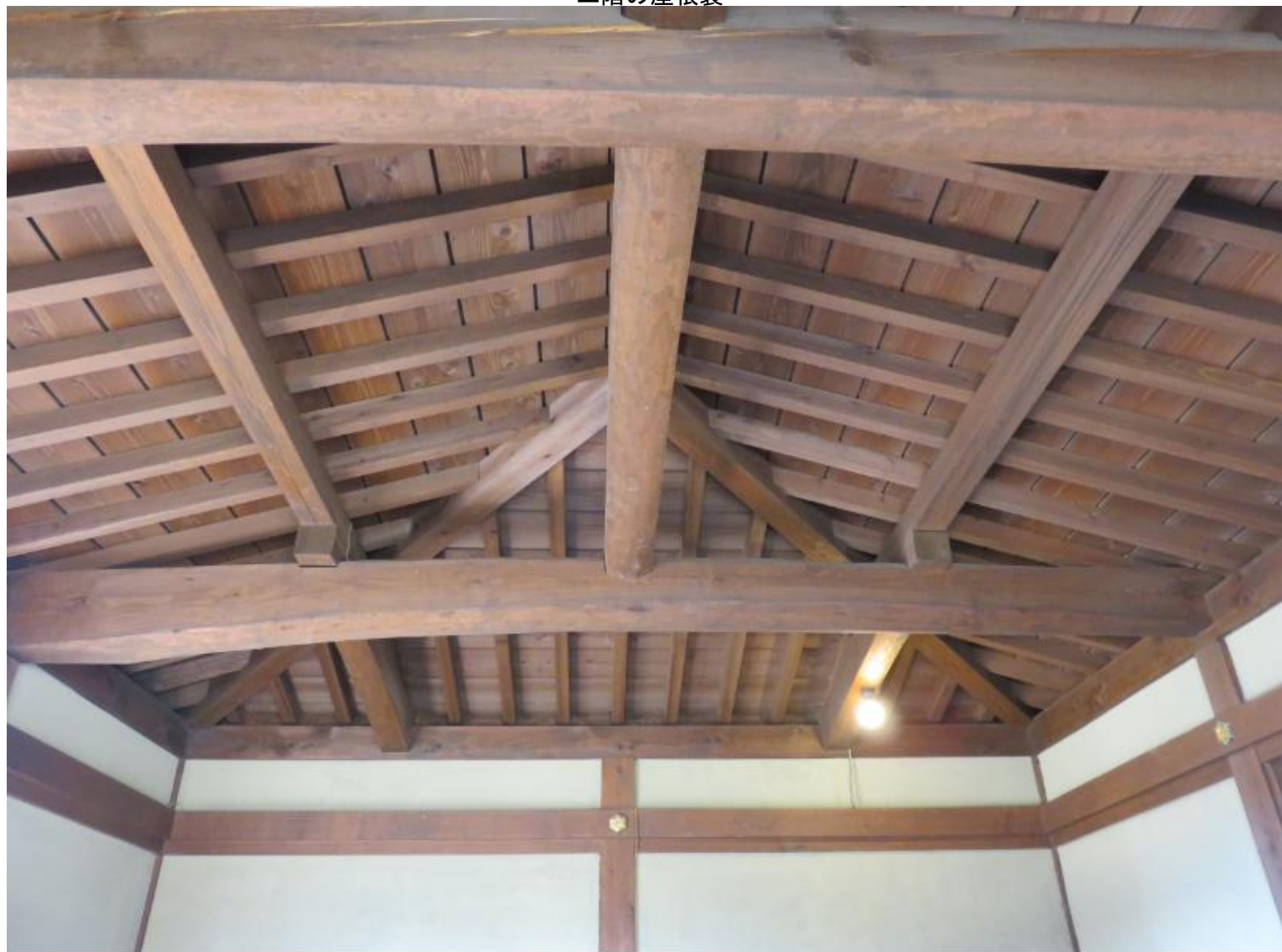
二階の屋根裏
