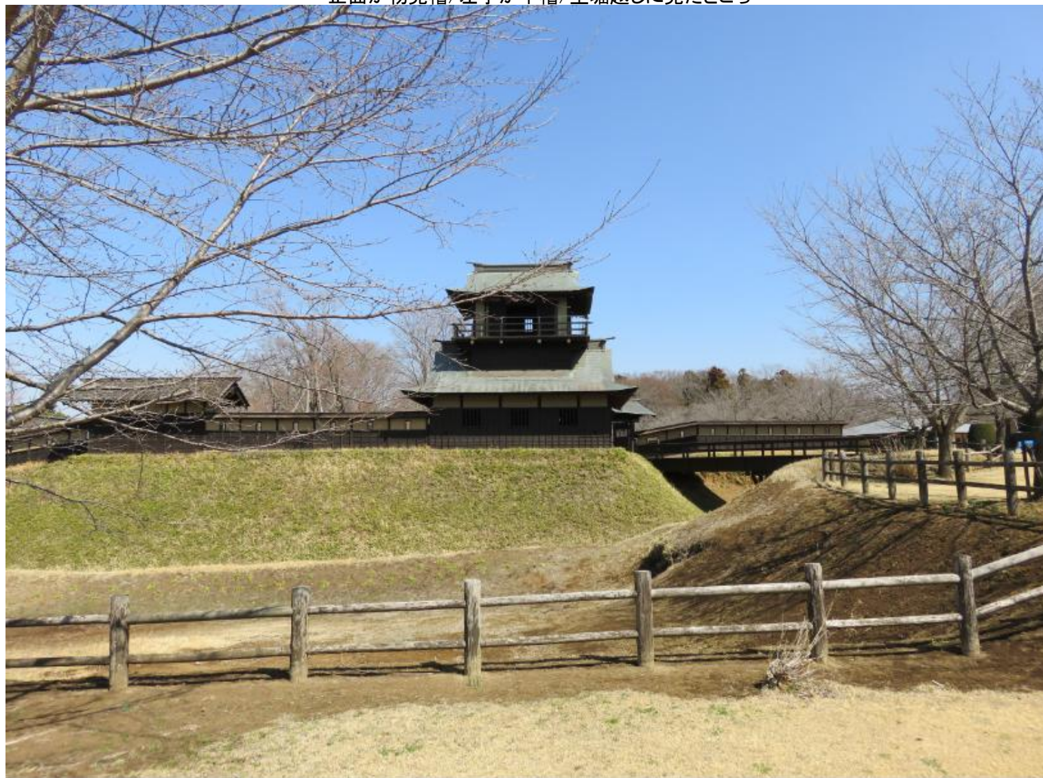
正面が物見櫓/左手が平櫓/空堀越しに見たところ
