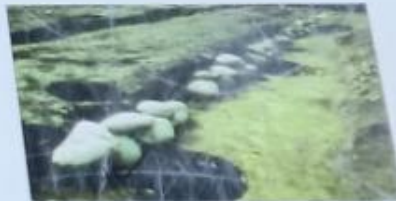
乱石積(北辺、東から)
