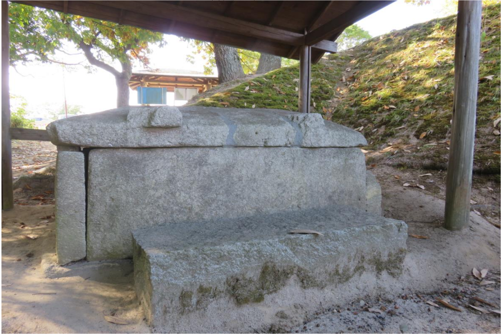
縄掛け突起も見て取れる
