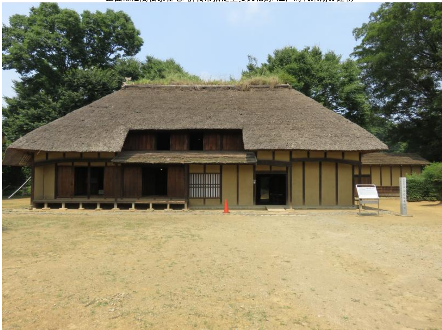
正面は旧関根家住宅/前橋市指定重要文化財/江戸時代末期の建物
