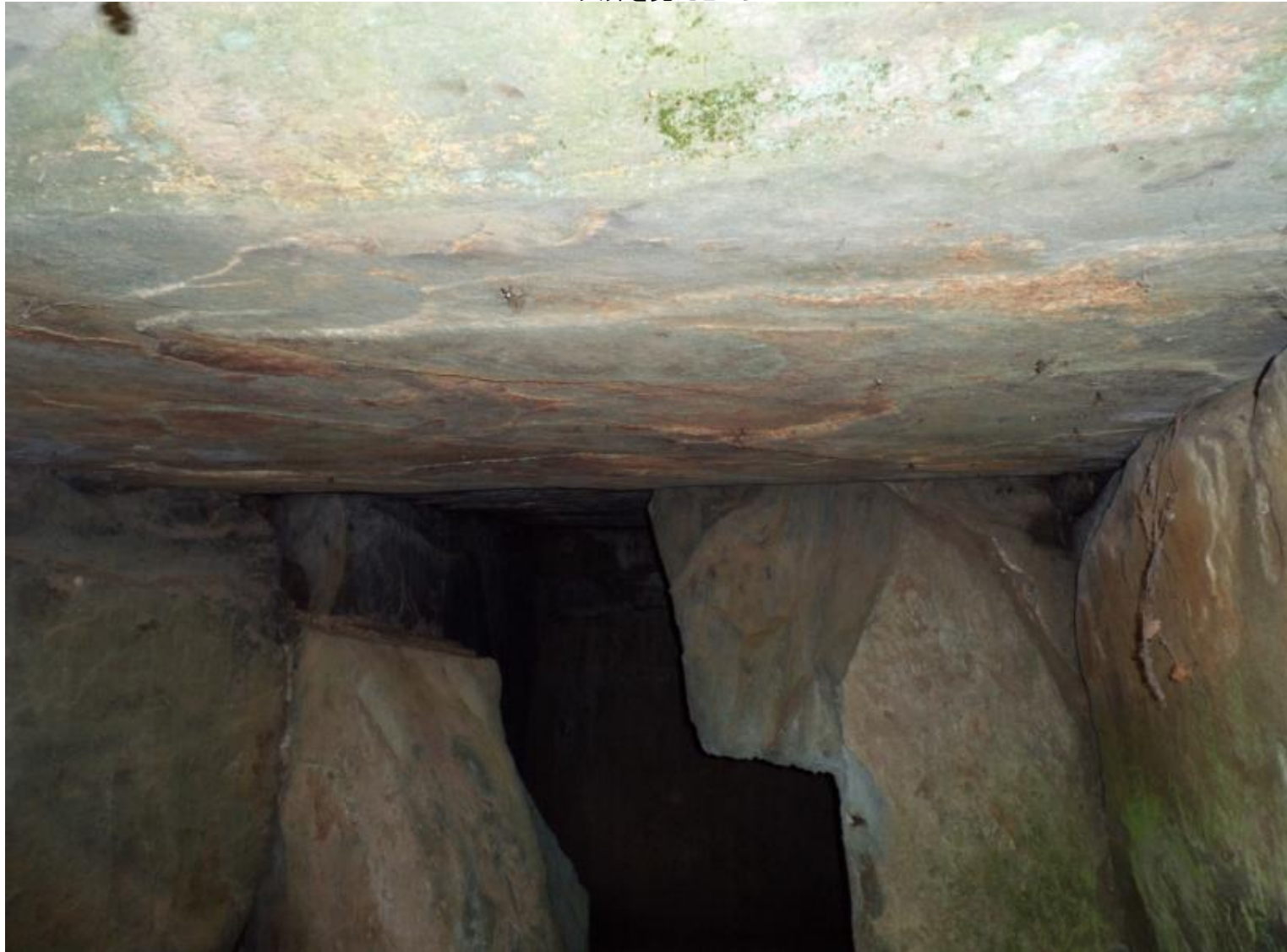
天井を見たところ
