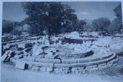
Φιλιππεϊόν. Πριν την αναστηλωτική επέμβαση. Philippeion. Before restoration. Philippeion. Bevor der Teilrekonstruktion.
