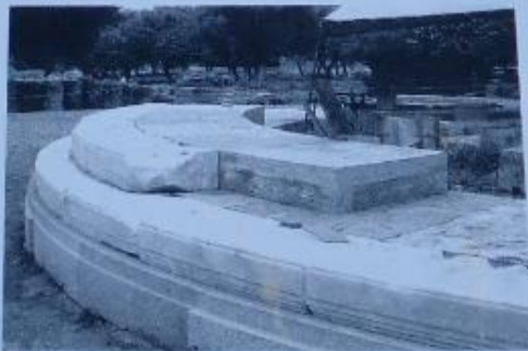
Φιλιππεϊόν. Κατά την διάρκεια του αναστηλωτικού έργου. Philippeion. During restoration work. Philippeion. Während der Teilrekonstruktion.
