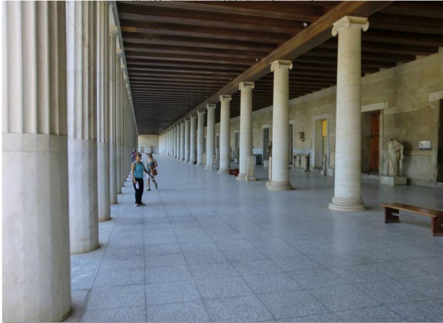
一階/外側の柱はドリス式、中間の柱はイオニア式のオーダー
