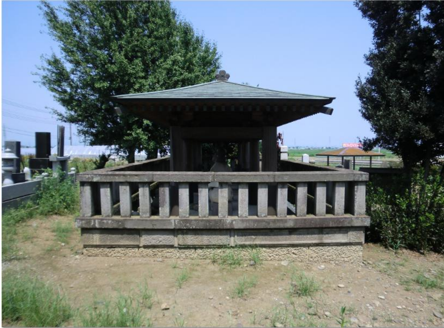
覆屋の左側面を見る
