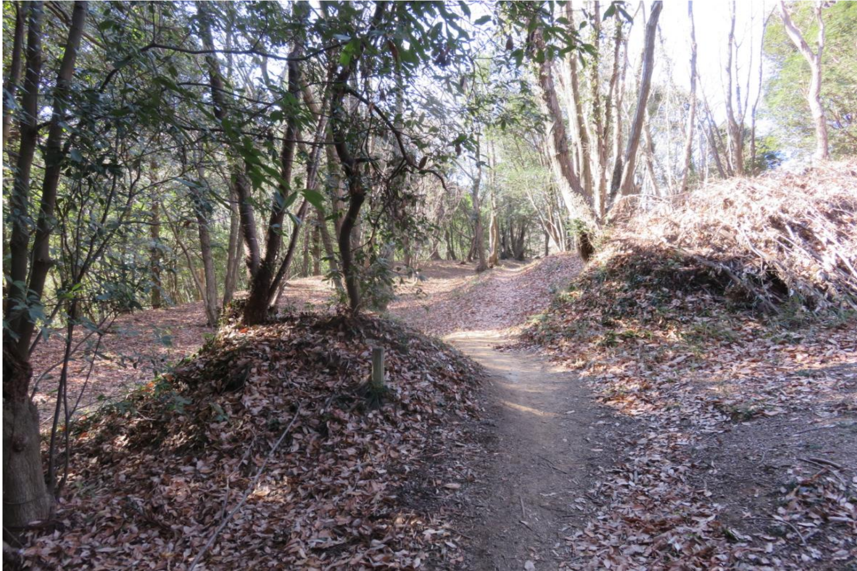
現状土橋となっている郭4の虎口状を見たところ
