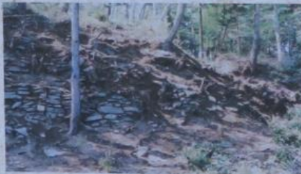
▲ 腰郭石垣正面(南東より)
