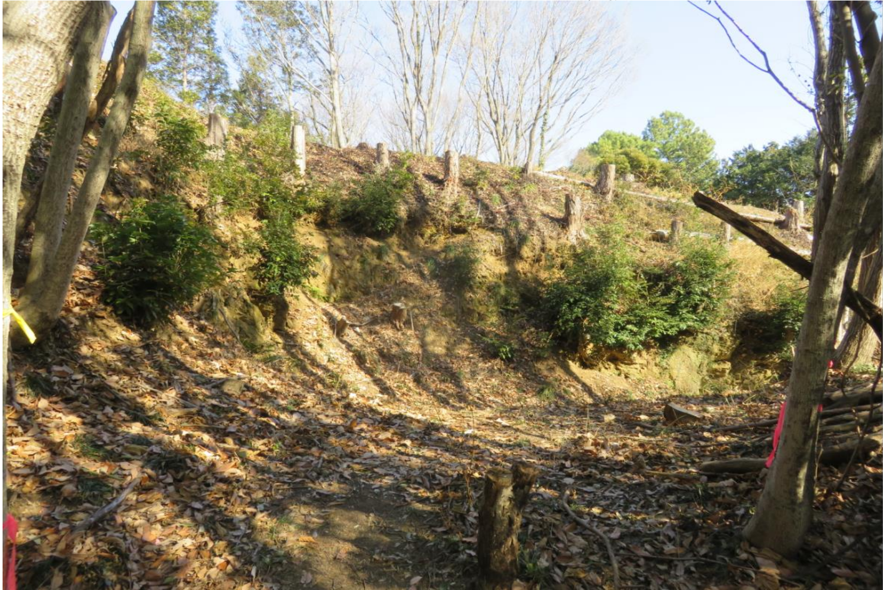
これは、そこで振り返って堀切(大堀切)を見たところ/正面の上部は郭2
