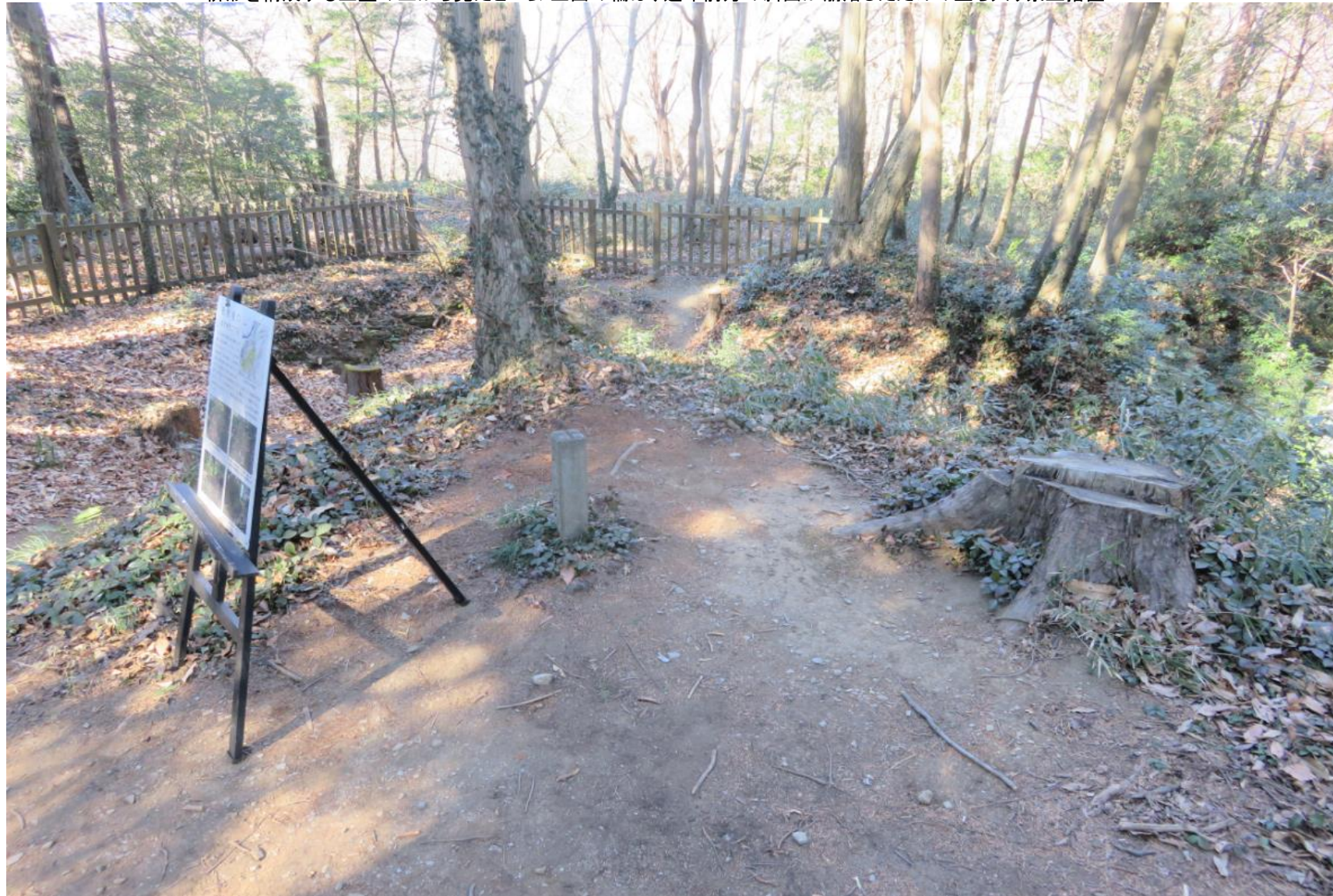
柵形を構成する土塁の上から見たところ/正面の柵は、近年前方の斜面が崩落したための立ち入り禁止措置
