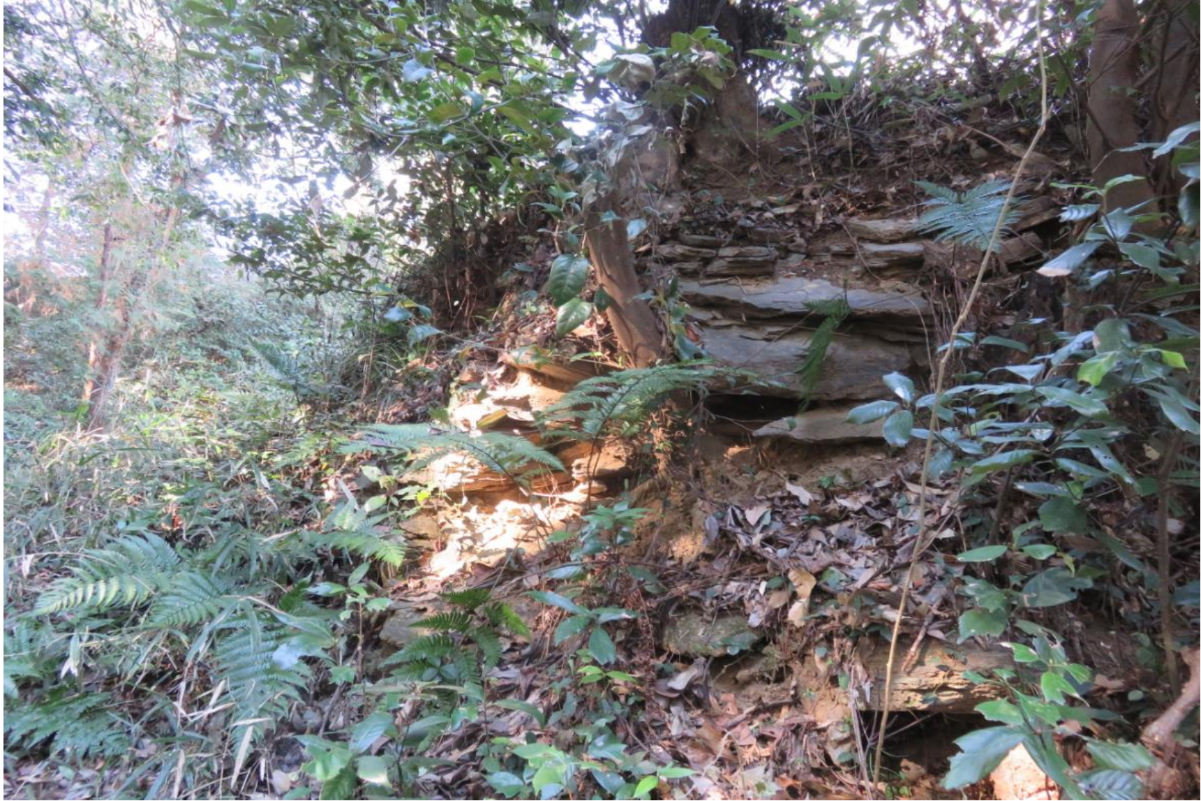
結晶片岩(地元の緑泥石片岩)の平石を水平に積んだ様子が見て取れる
