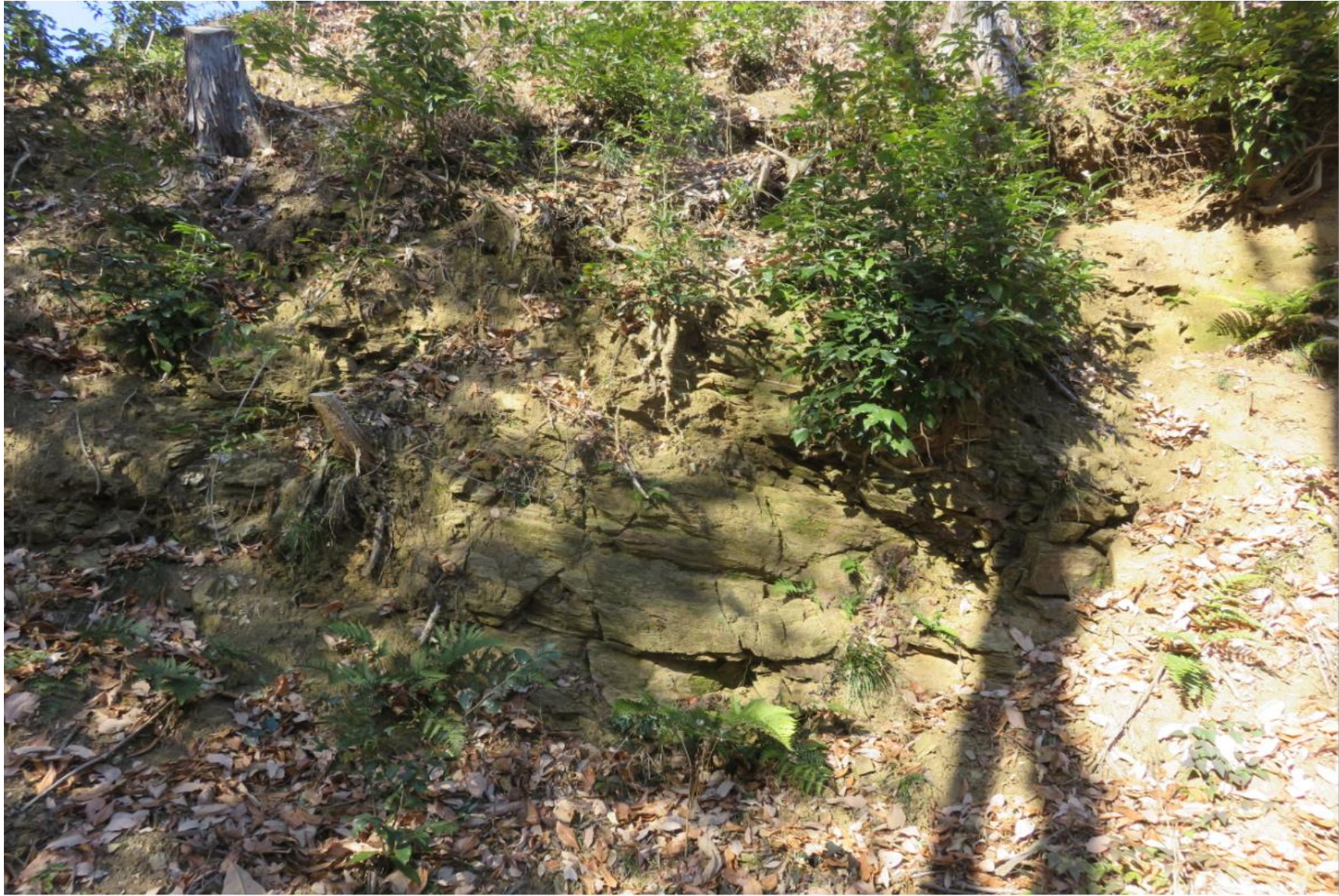
岩盤を削り込んでいる
