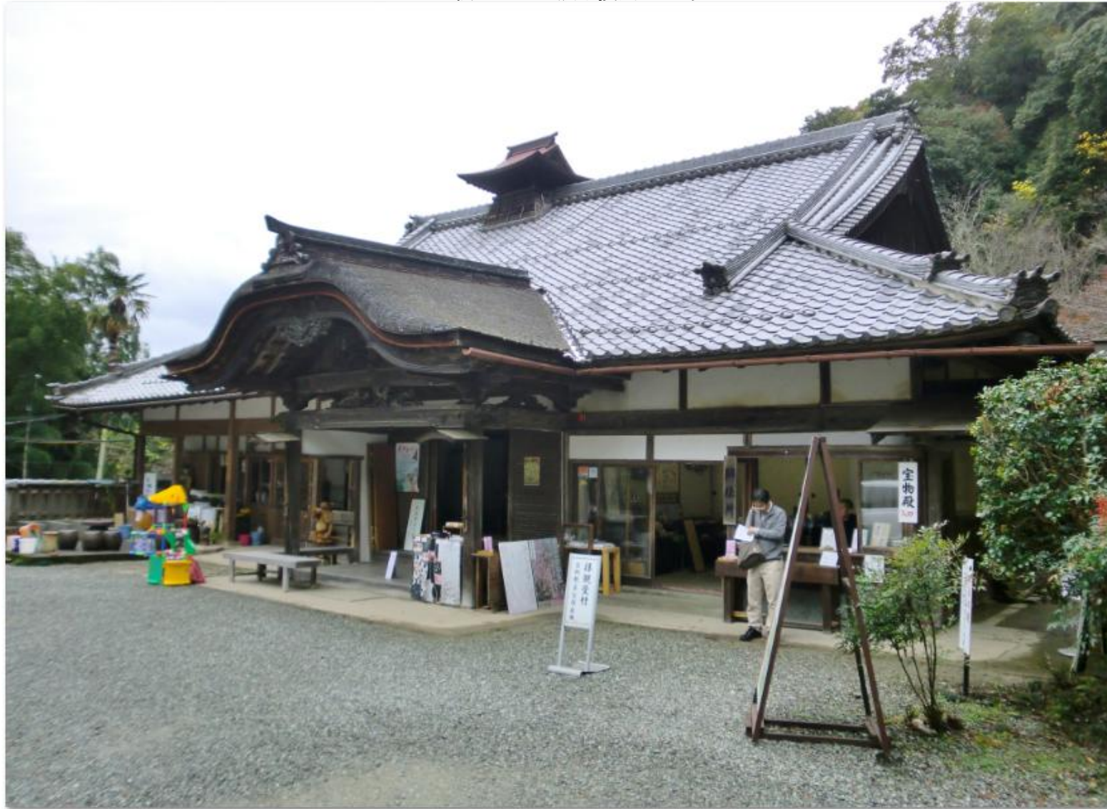
屋根の上に立派な換気口がある
