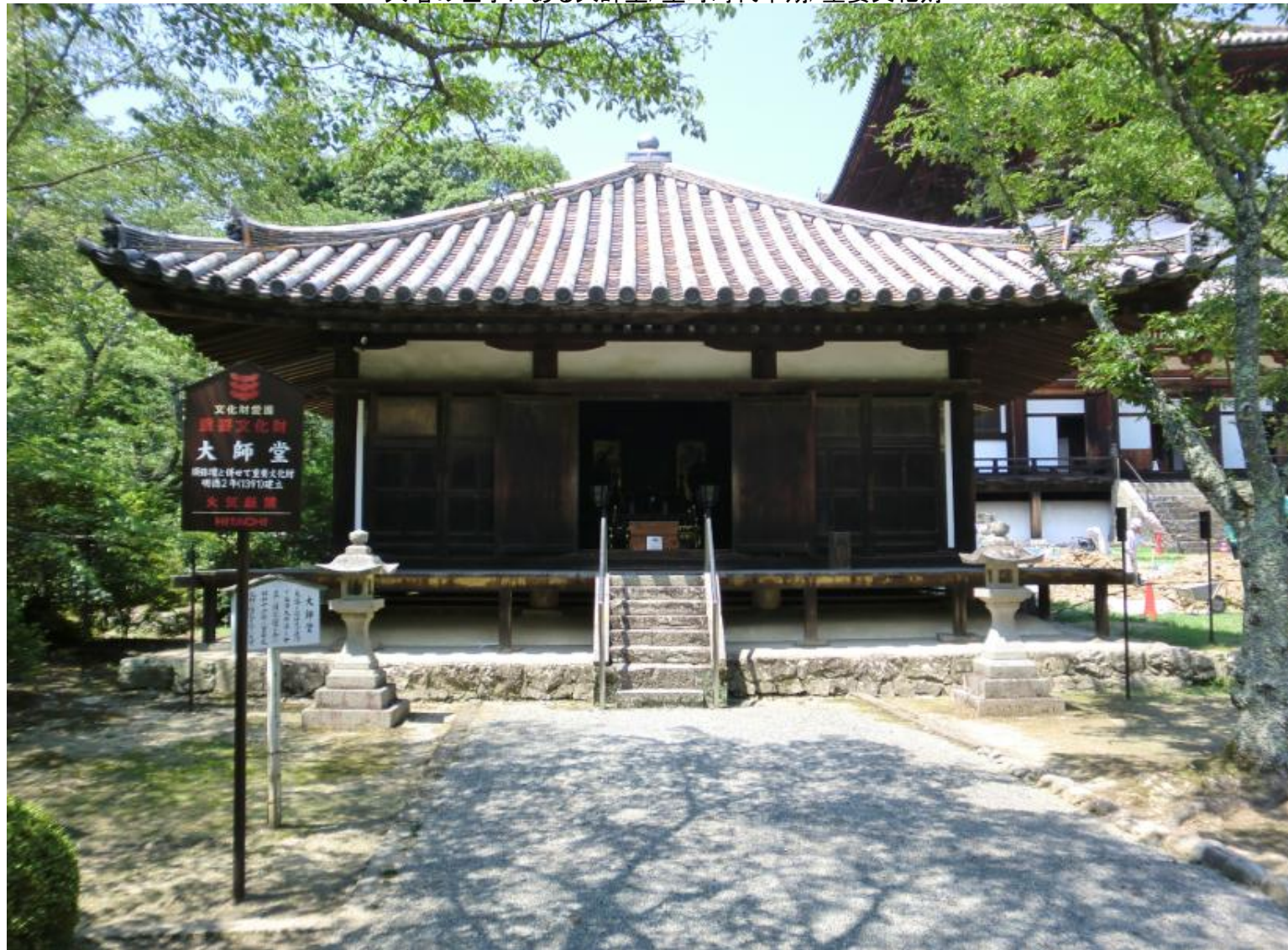
大塔の左手にある大師堂/室町時代中期/重要文化財
