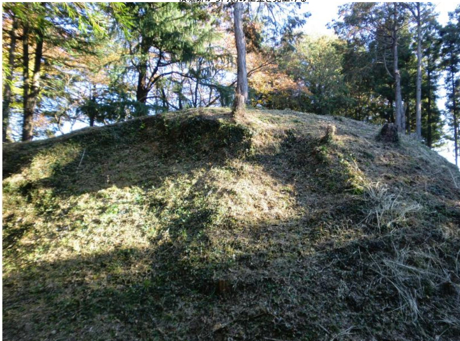
横堀跡から内側の土塁を見上げる
