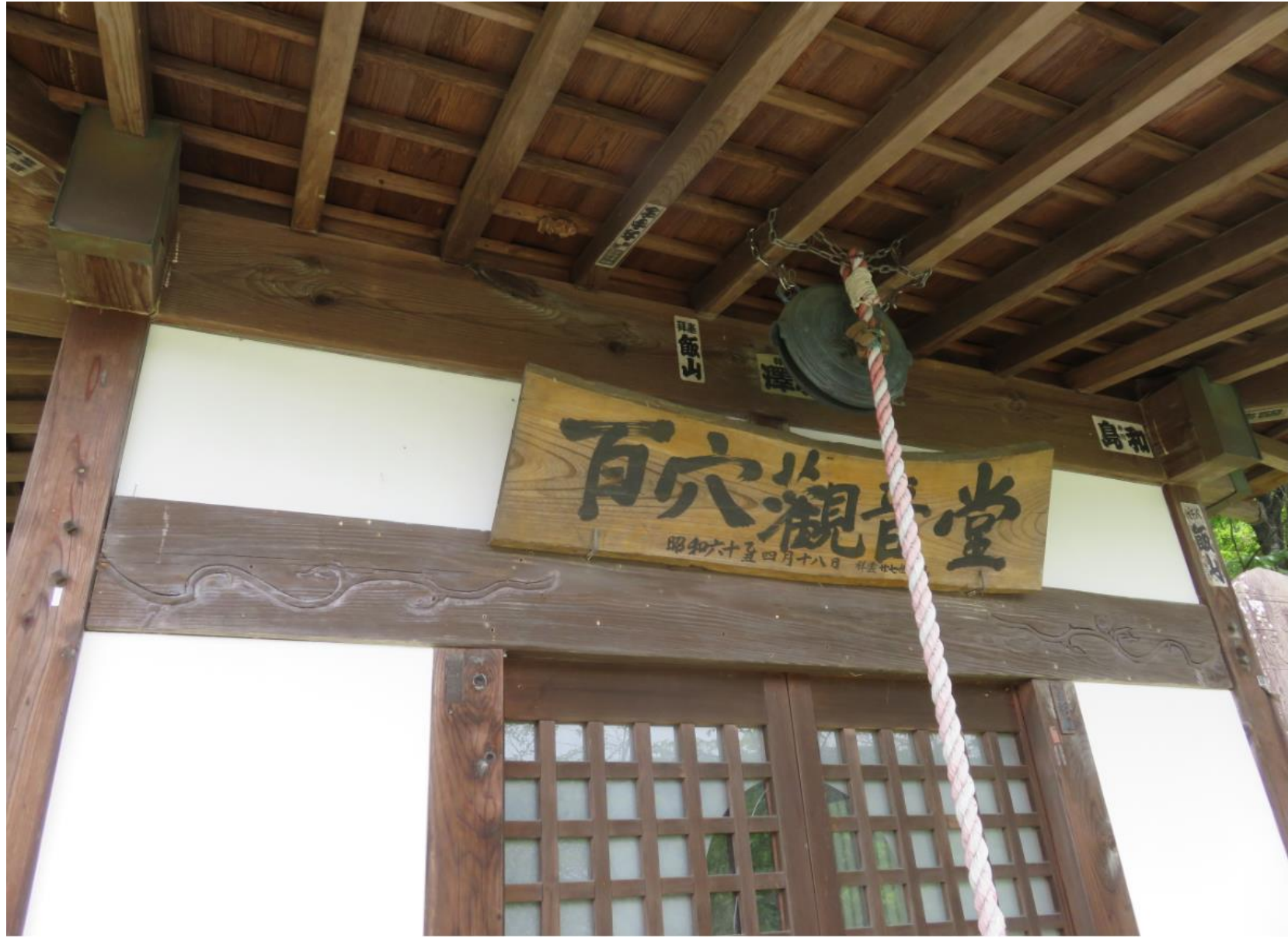
この建物は、東群と西群の間に建つ百穴観音堂
