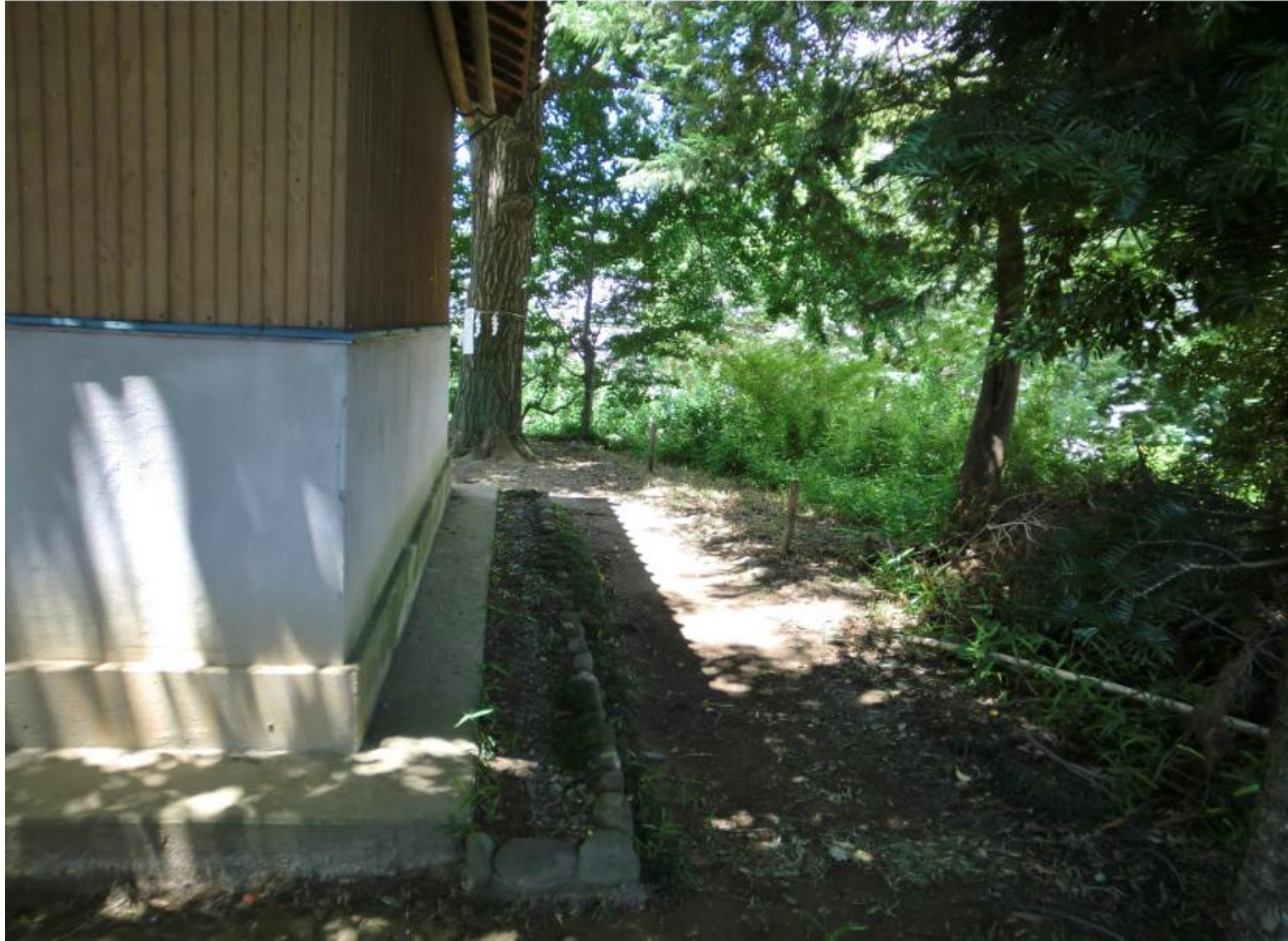
社殿の背後の状況を見る
