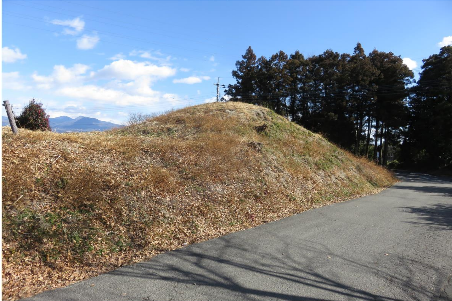
南西側から見たところ
