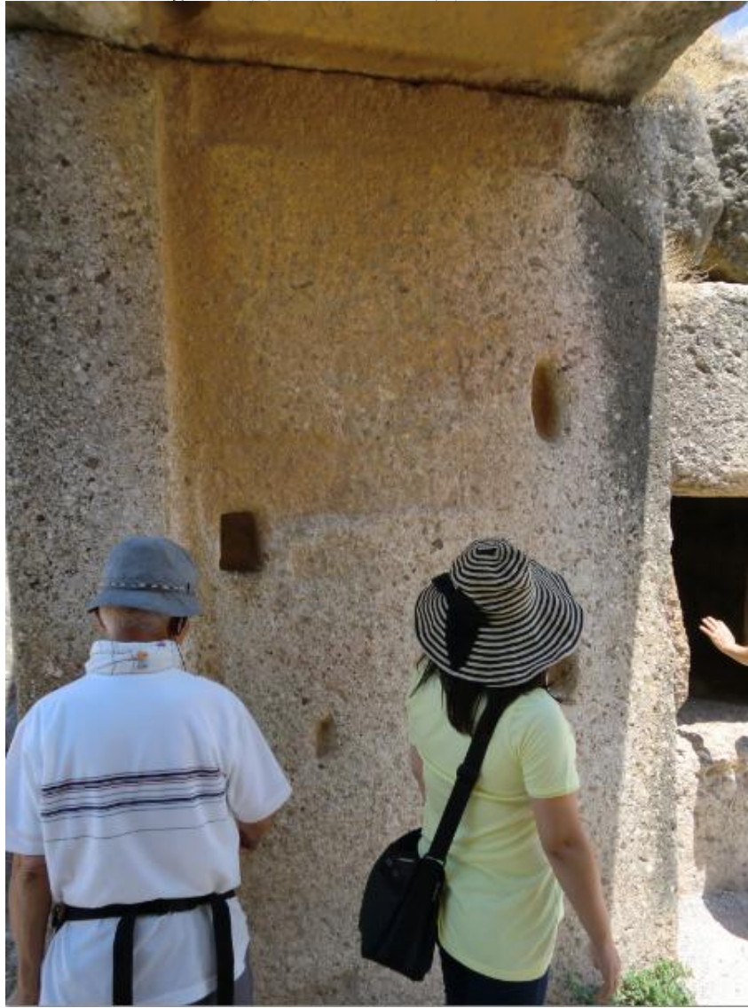
扉が取り付けられていた穴が残っている
