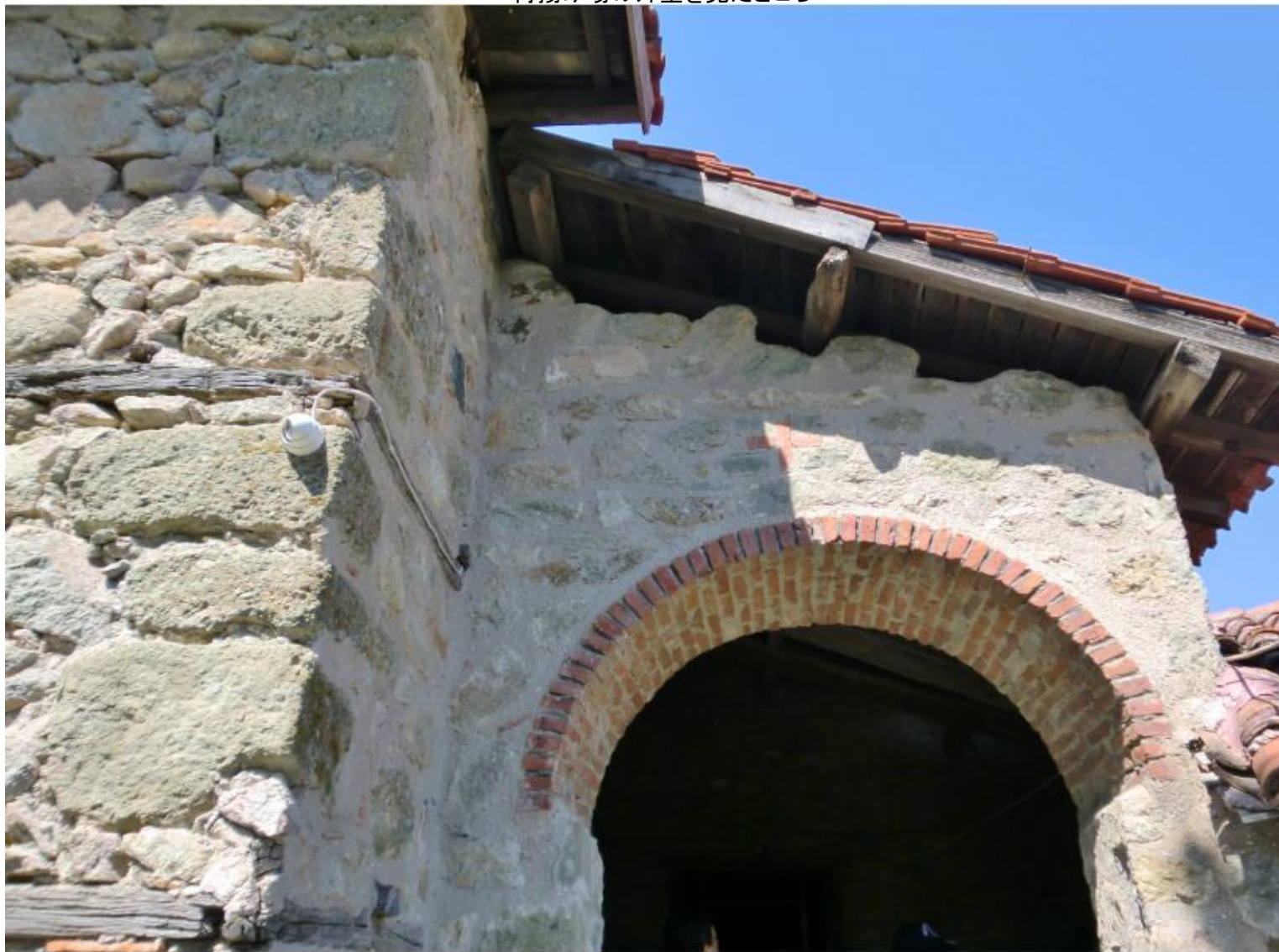
荷揚げ場の外壁を見たところ
