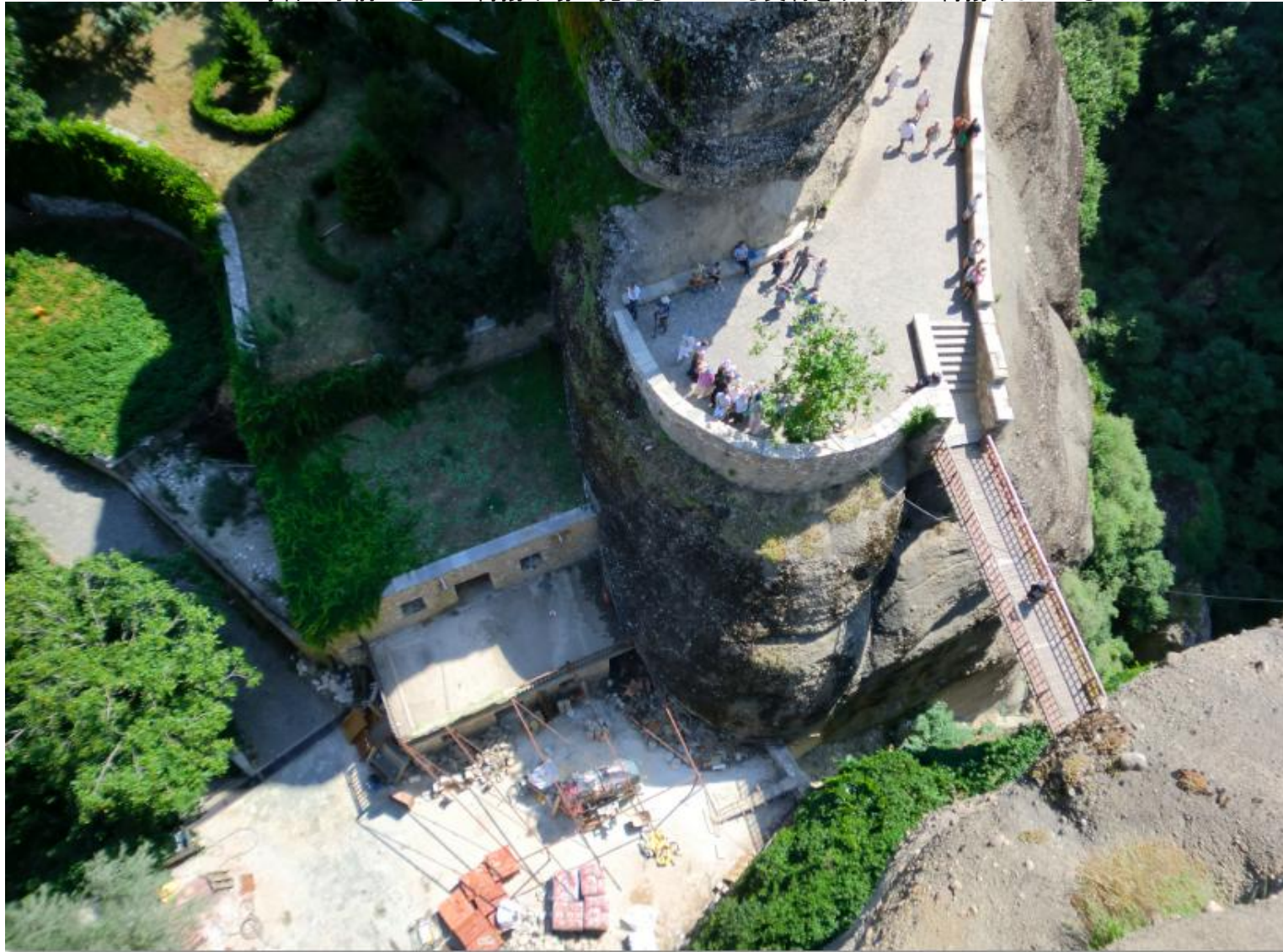
奇岩の手前に地上の荷揚げ場が見える/ここから資材をウインチで荷揚げしている
