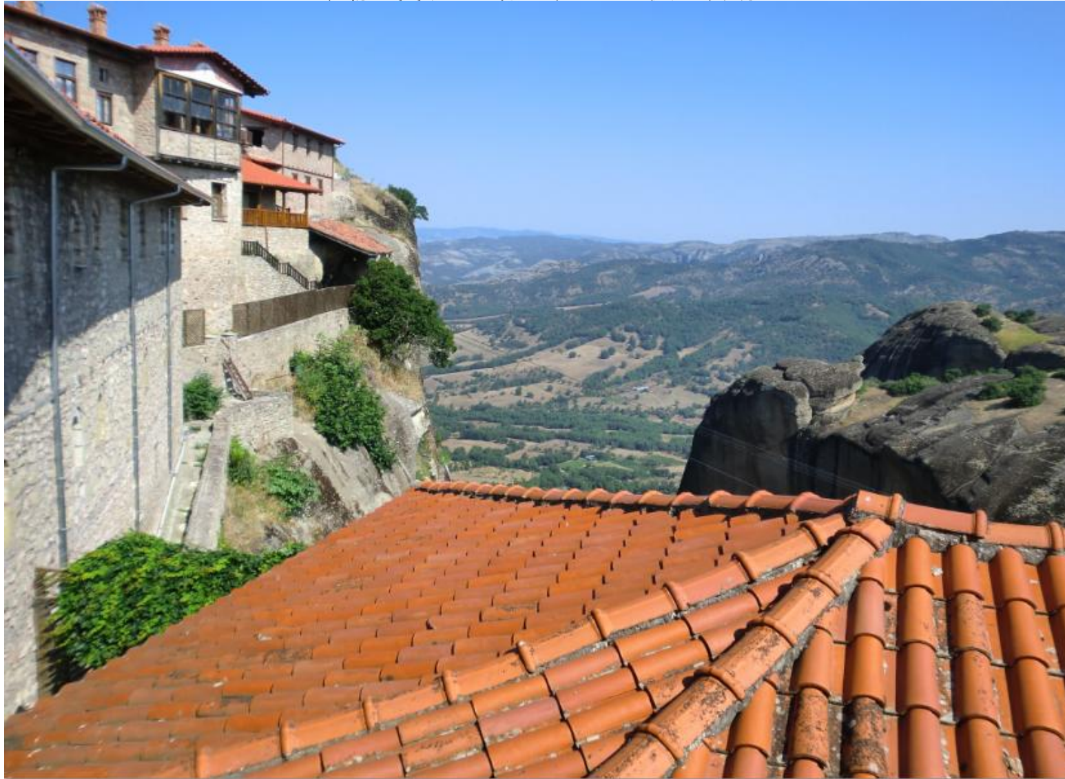
建物がそそり立った岩山に建っている状況がよく分かる
