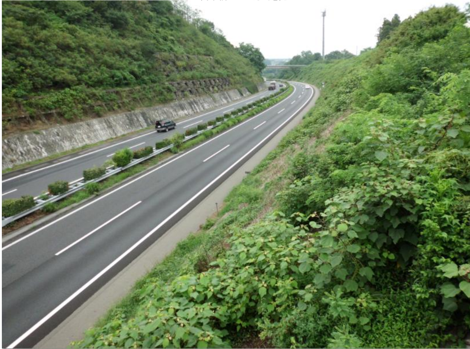
高架橋から西方向を見る
