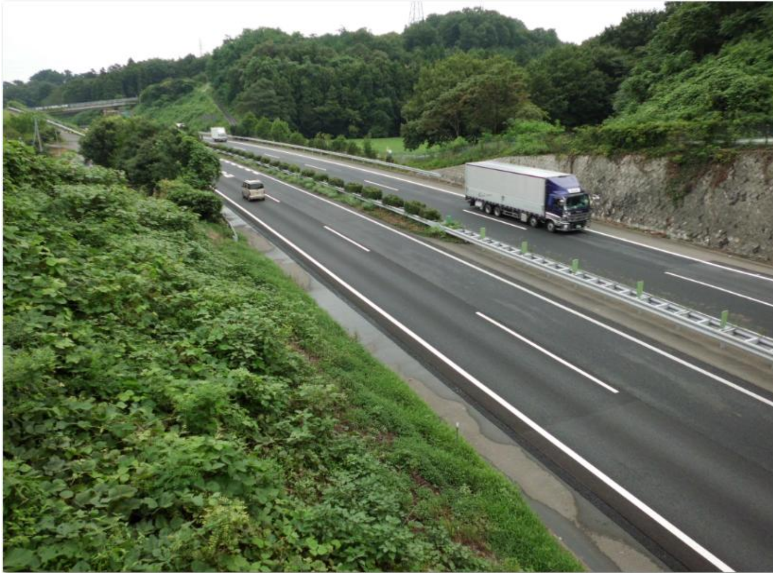
高架橋から東方向を見る
