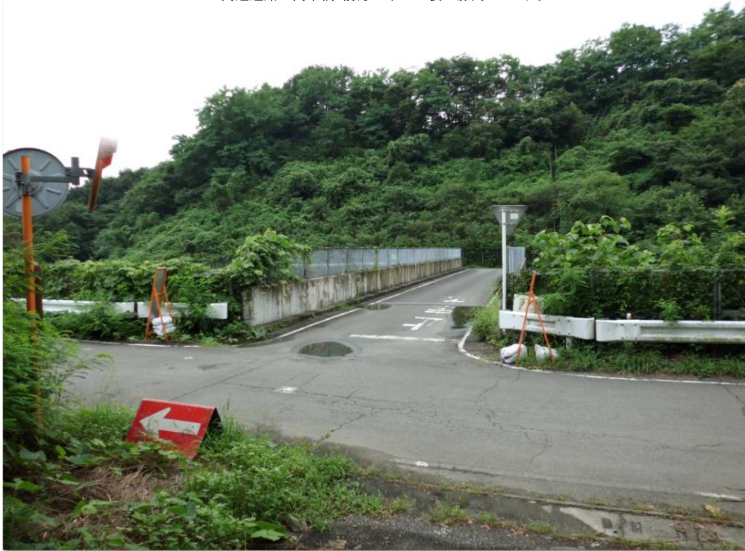
高速道路の高架橋/前方の木々の裏が藤岡ゴルフクラブ
