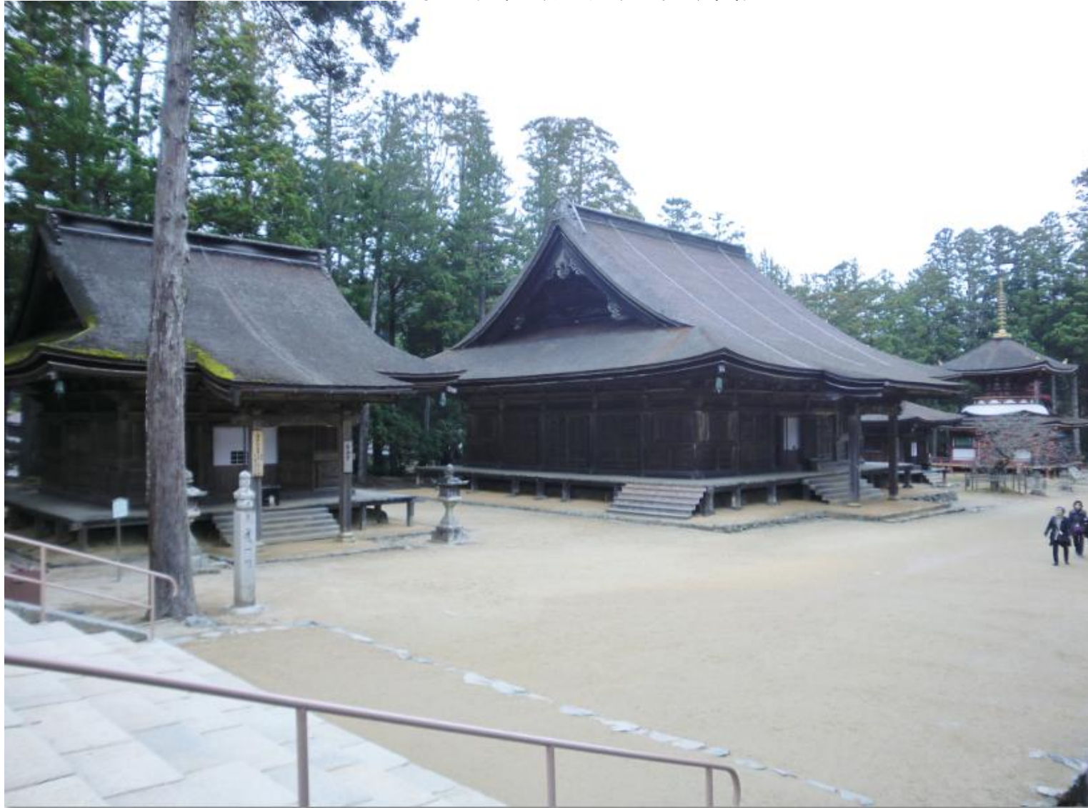
左手から愛染堂、大会堂、三昧堂、東塔
