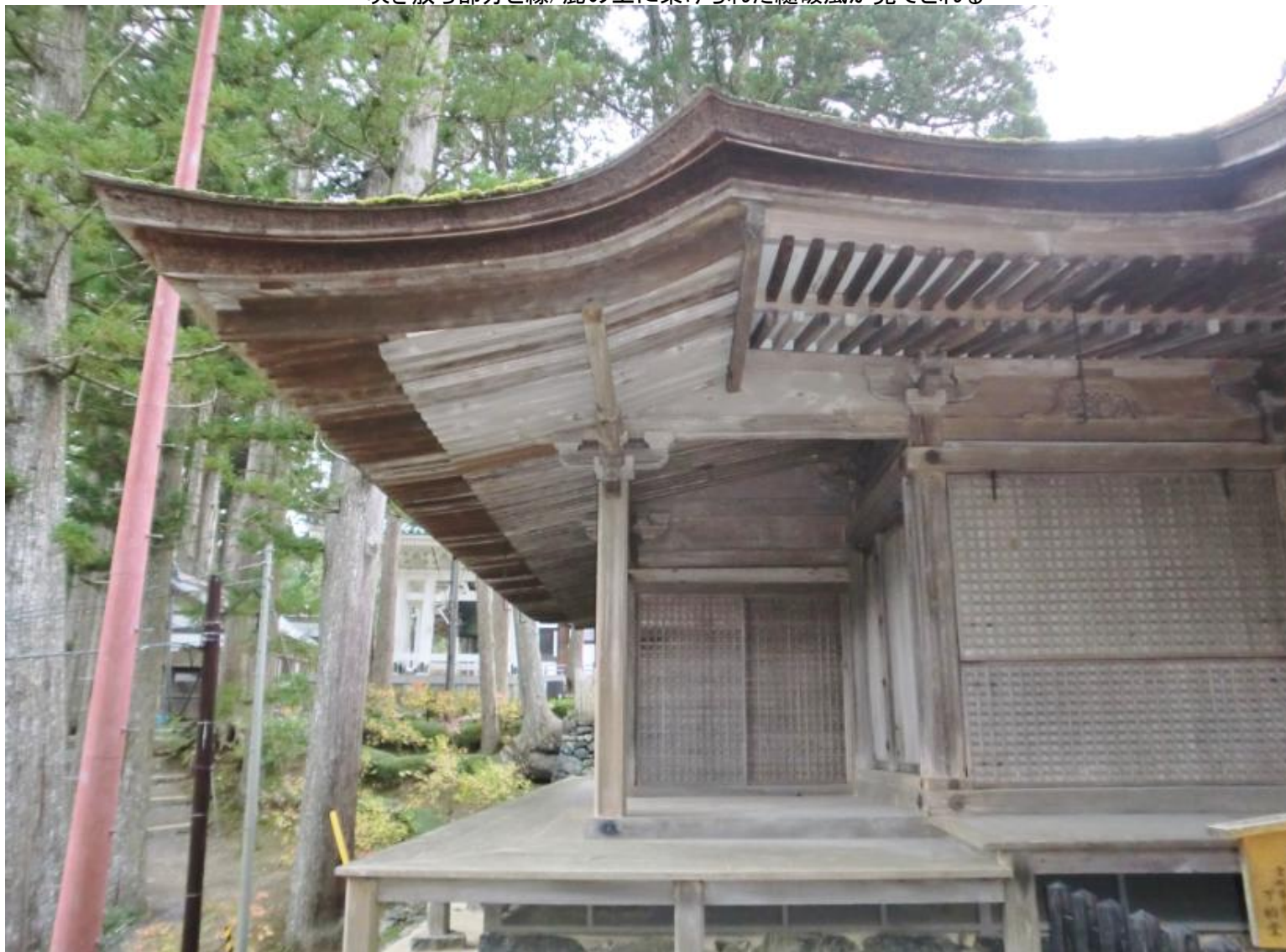
吹き放ち部分と縁/庇の上に架けられた継破風が見てとれる
