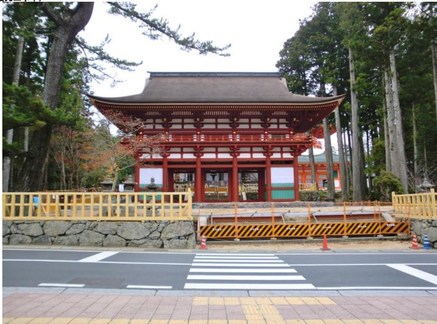
壇上伽藍(だんじょうがらん) 中門址(復元工事中)
