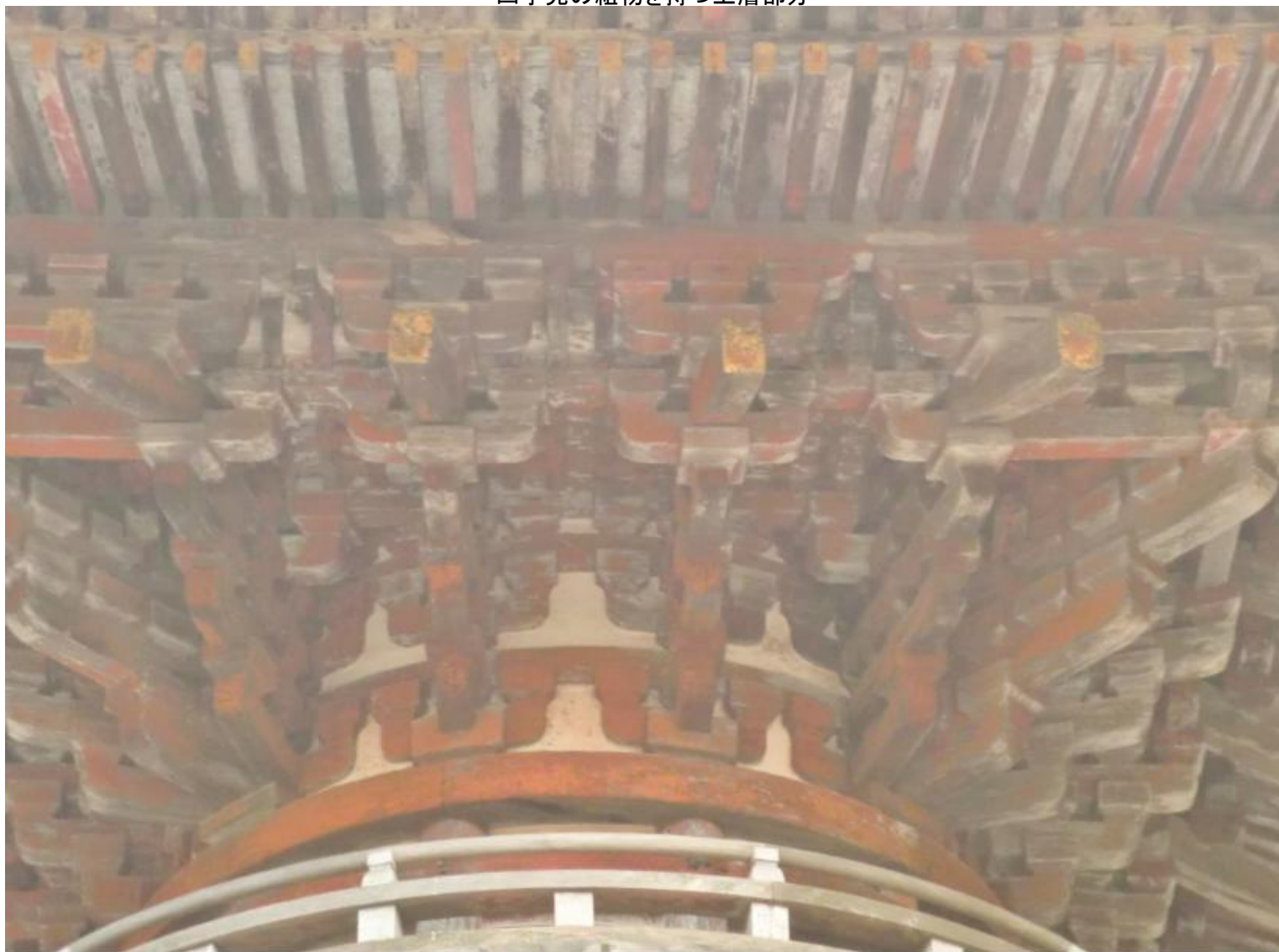
四手先の組物を持つ上層部分
