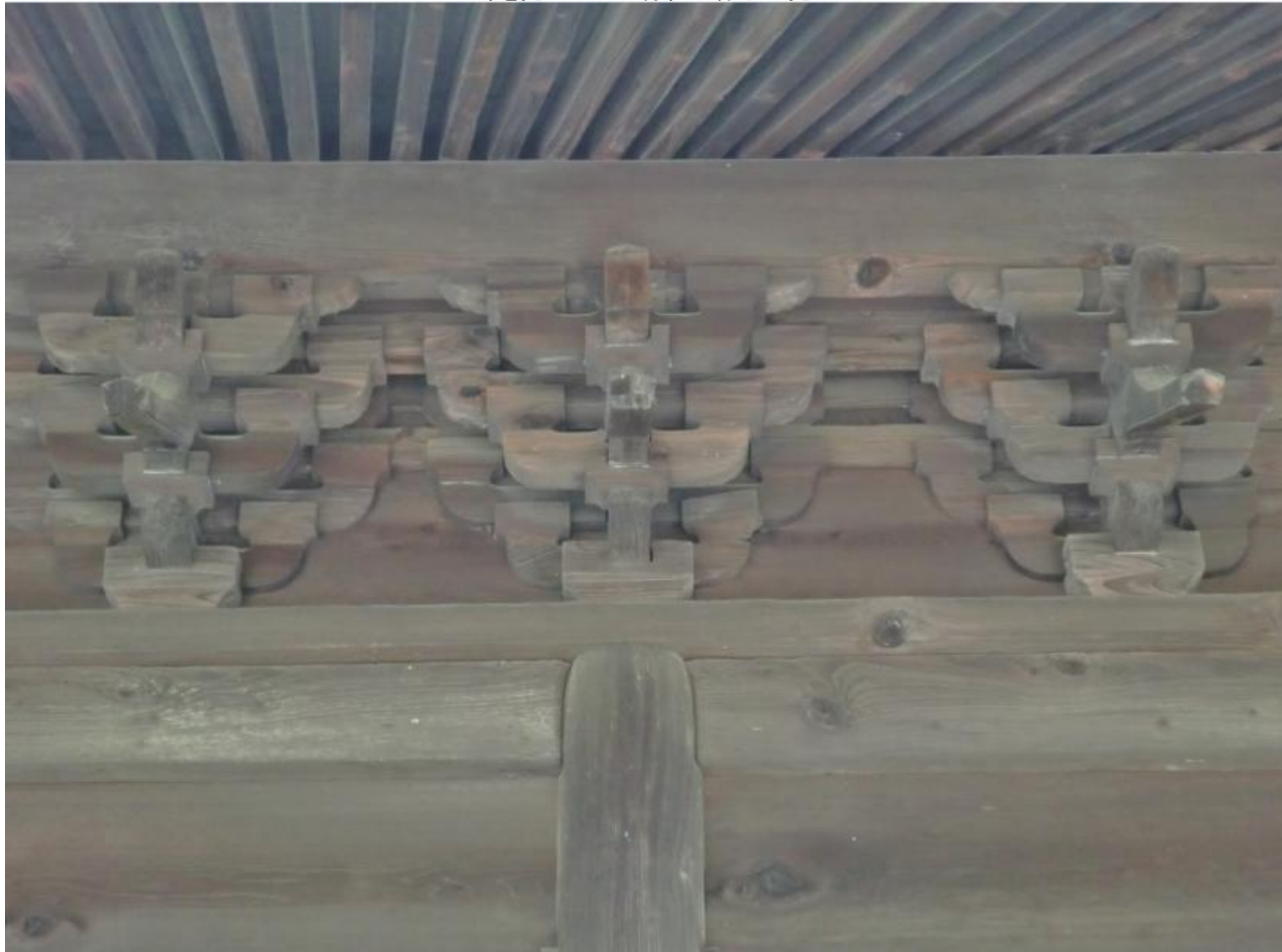
上部を見たところ/粽柱の様子が見てとれる
