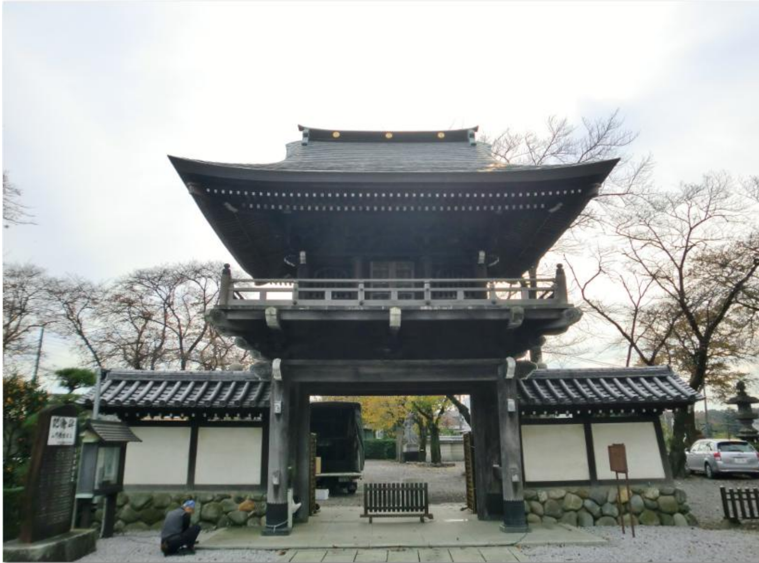
楼門を境内から見たところ
