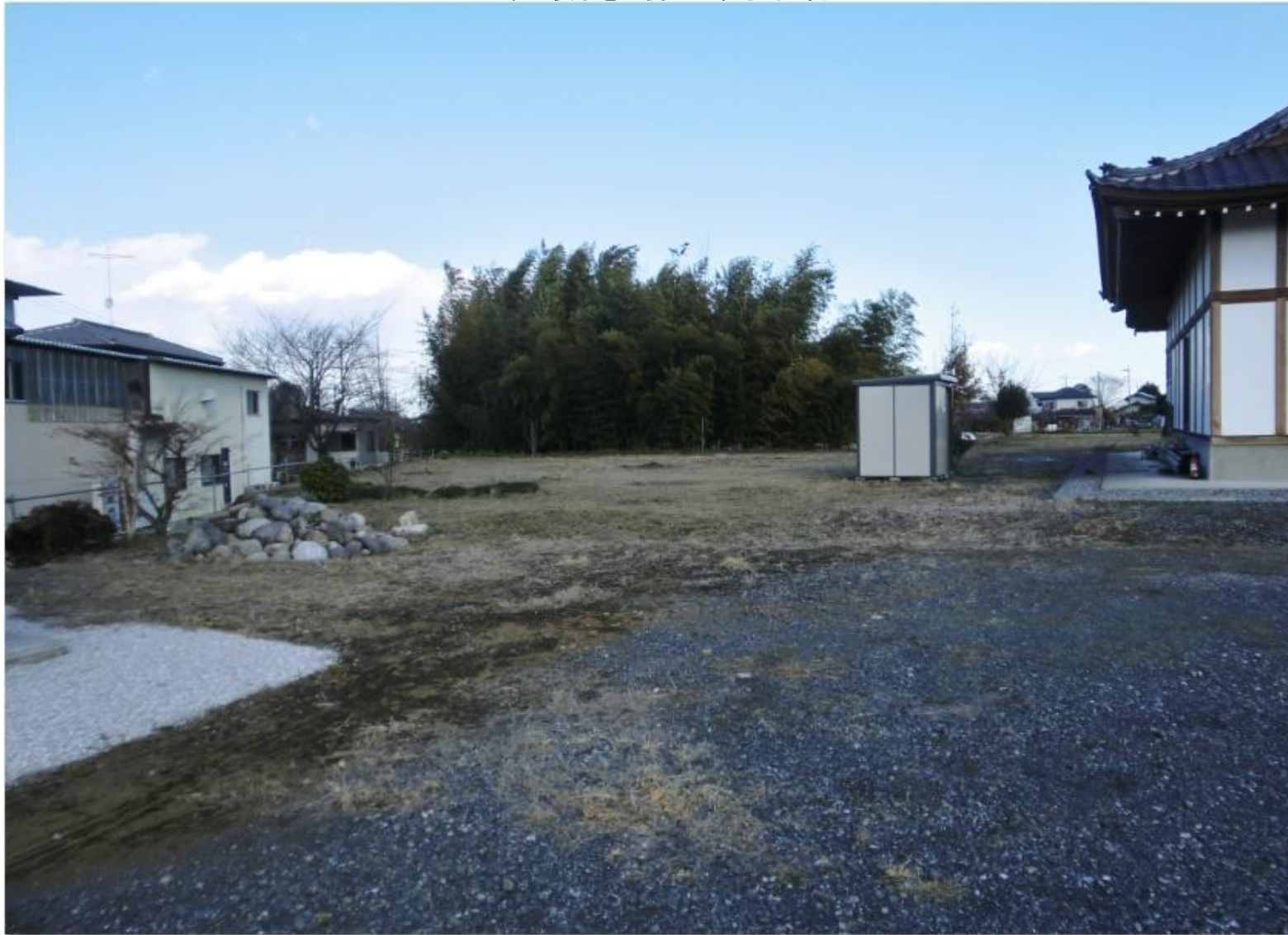
本堂裏手を西側から東方向に見る
