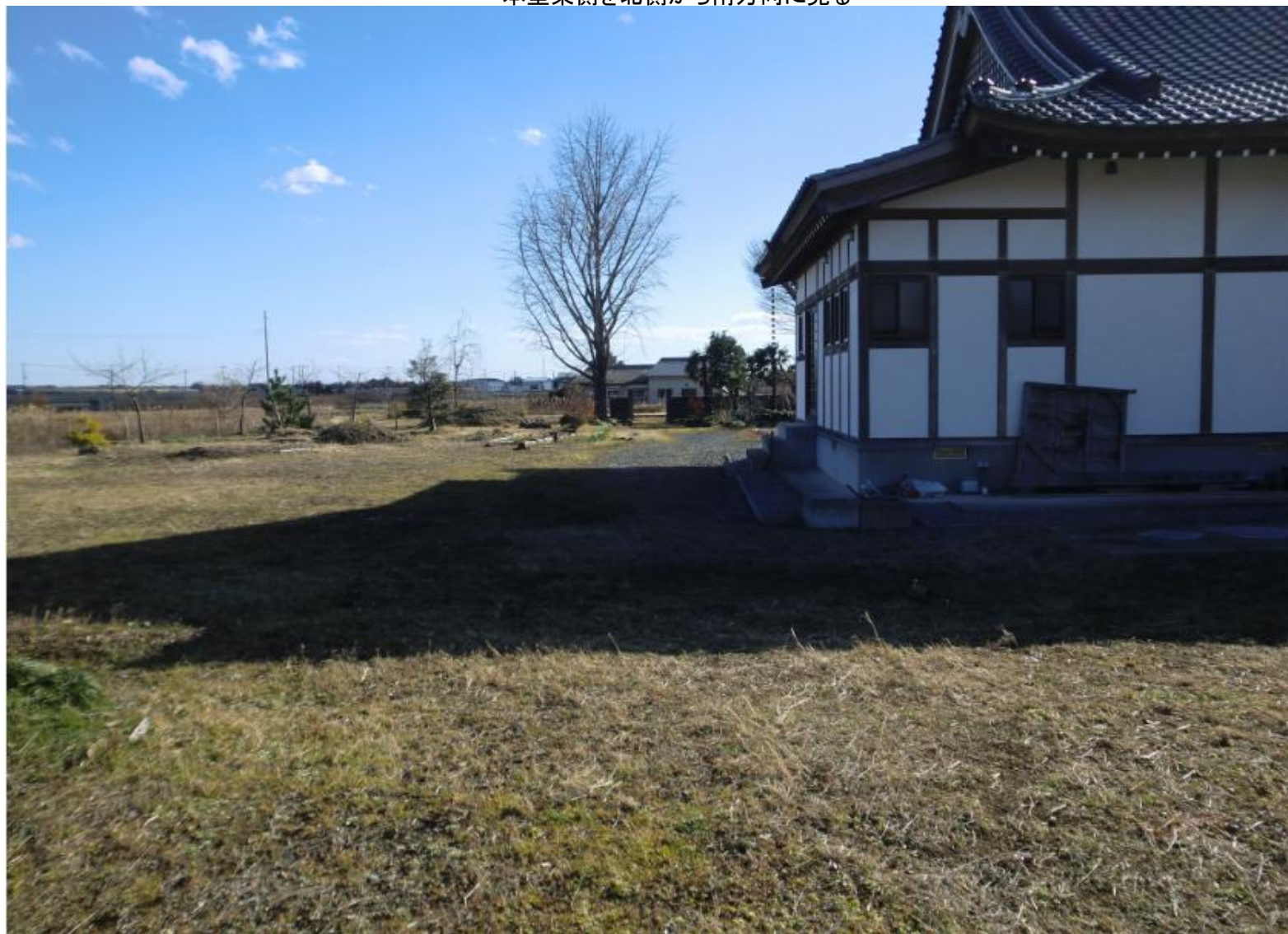
本堂東側を北側から南方向に見る
