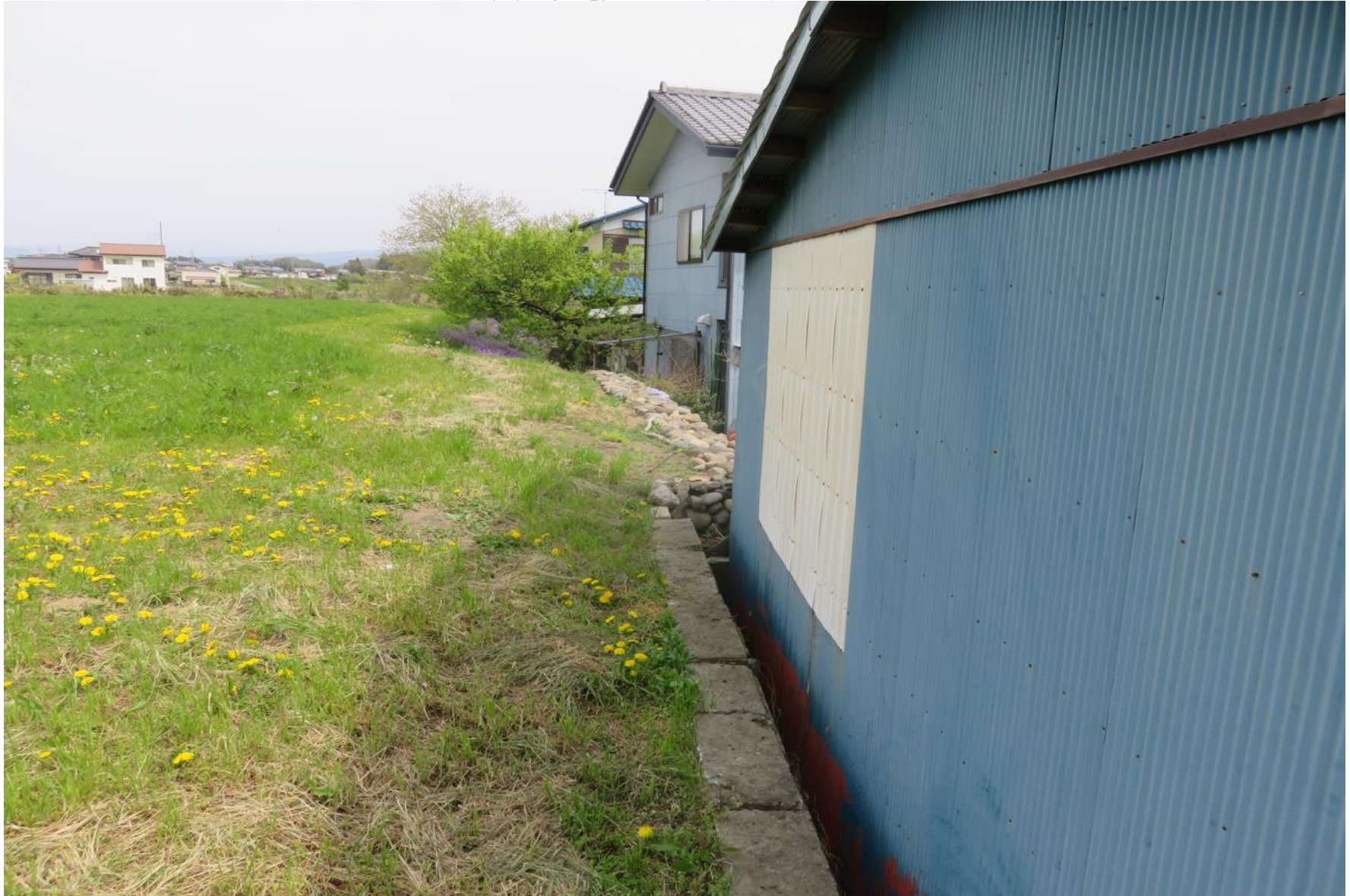
居館の東辺を見たところ/2箇所の張出がある
