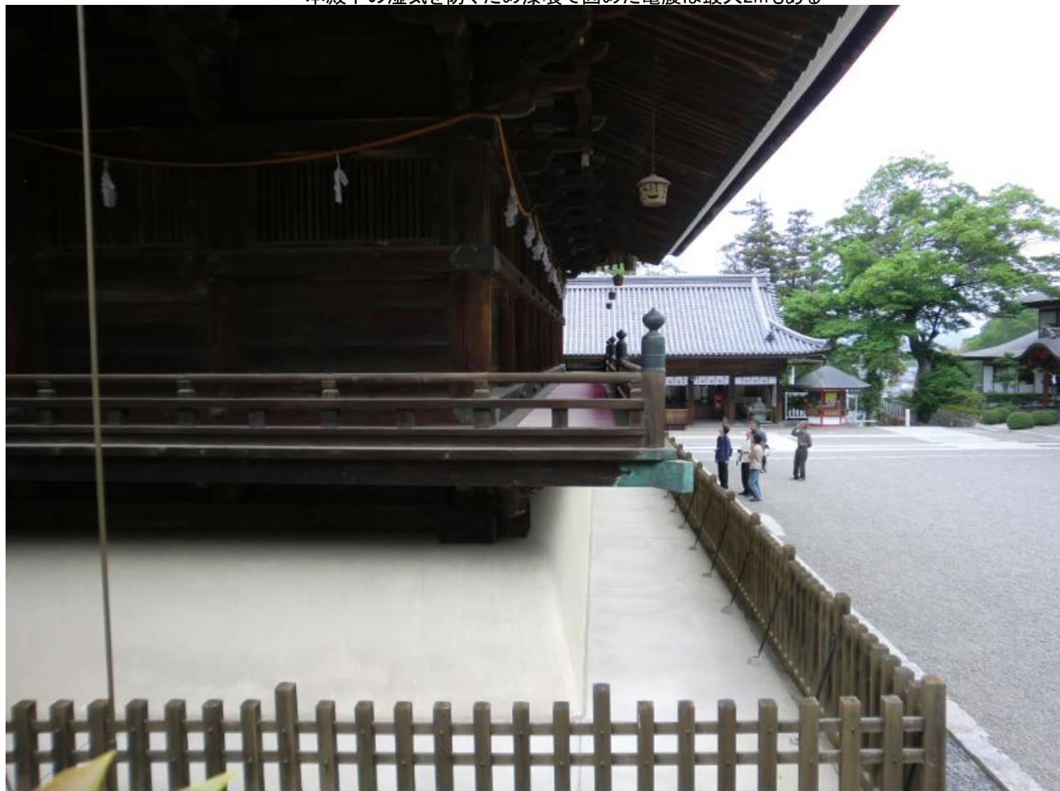
本殿下の湿気を防ぐため漆喰で固めた亀腹は最大2mもある
